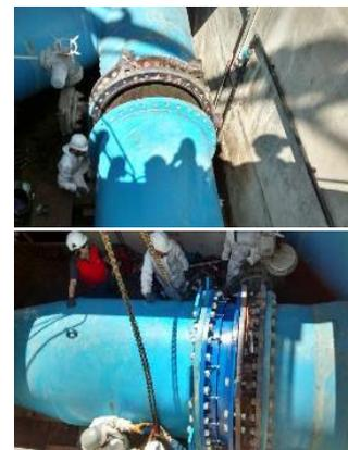
La réparation définitive, consistant au changement du joint de démontage ainsi qu'à la mise en œuvre d'un support assurant la tenue mécanique des éléments hydrauliques, a eu lieu le 18 avril 2018. Aucun travaux de terrassement n'ont été nécessaire, l'intervention ayant lieu depuis l'intérieur du booster de taille suffisante .
