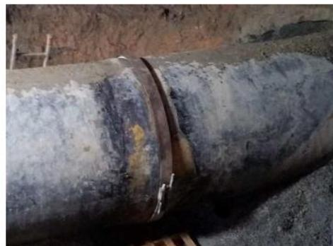
Un levé de géomètre a été effectué montrant une déviation angulaire d'environ 3° supplémentaires sur le plan horizontal par rapport au document technique établi lors de la construction.
