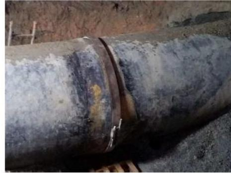
Un joint a été mis en place en compression par deux colliers : ce collier permet de maintenir le joint contre le bord de la tulipe du tuyau femelle et l'autre vient par-dessus pour compresser le tout.
