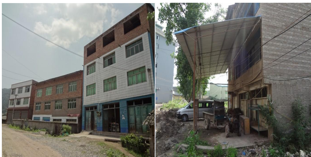
图 2-1 拟拆迁房屋照片
