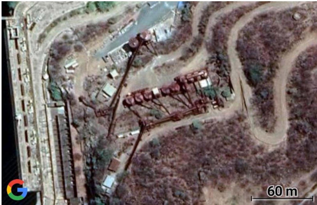
Figura 5-47 - HCB- vestígios das infraestruturas da época da construção da barragem
