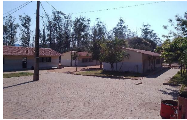
Blocos de salas de aulas, EPC da Liberdade
