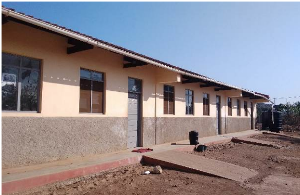
Escola Primária Completa Bairro Unidade
