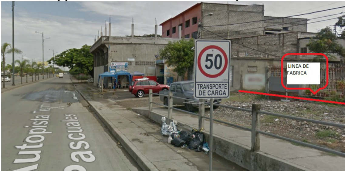
Fotografía 7-3 Línea de fábrica y predio afectado al fondo detrás de las carpas azules.
