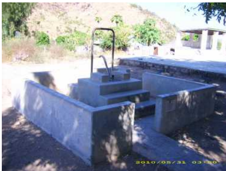
Photo 5 : Puits équipé de pompe à motricité humaine réalisé par FDL à Ambodiangezoka
