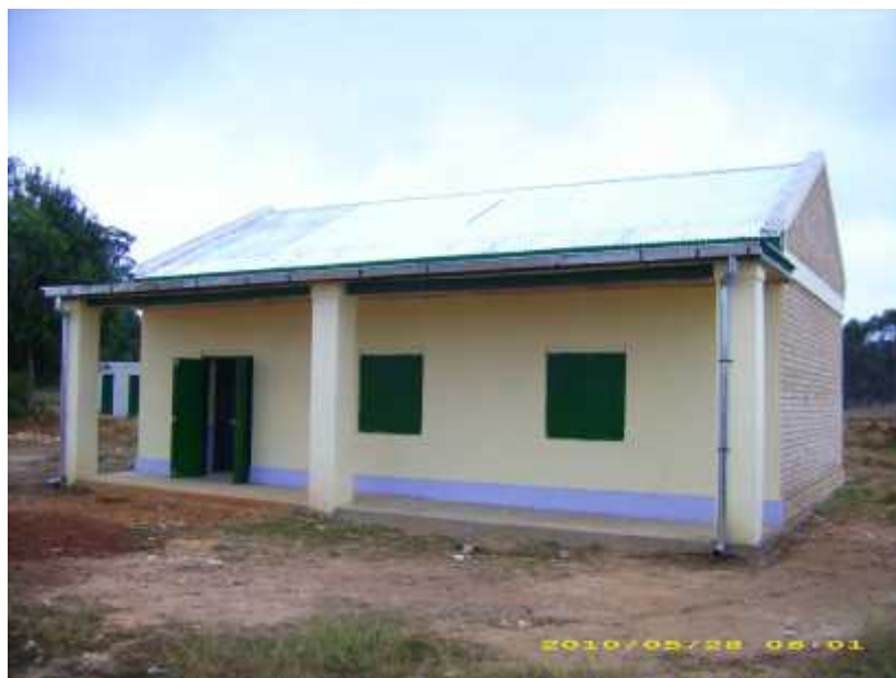
Photo 1 : Nouvelle école réalisée par FDL à Ambolomadinika
