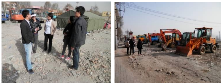
图 3-2 安置小区施工现场
