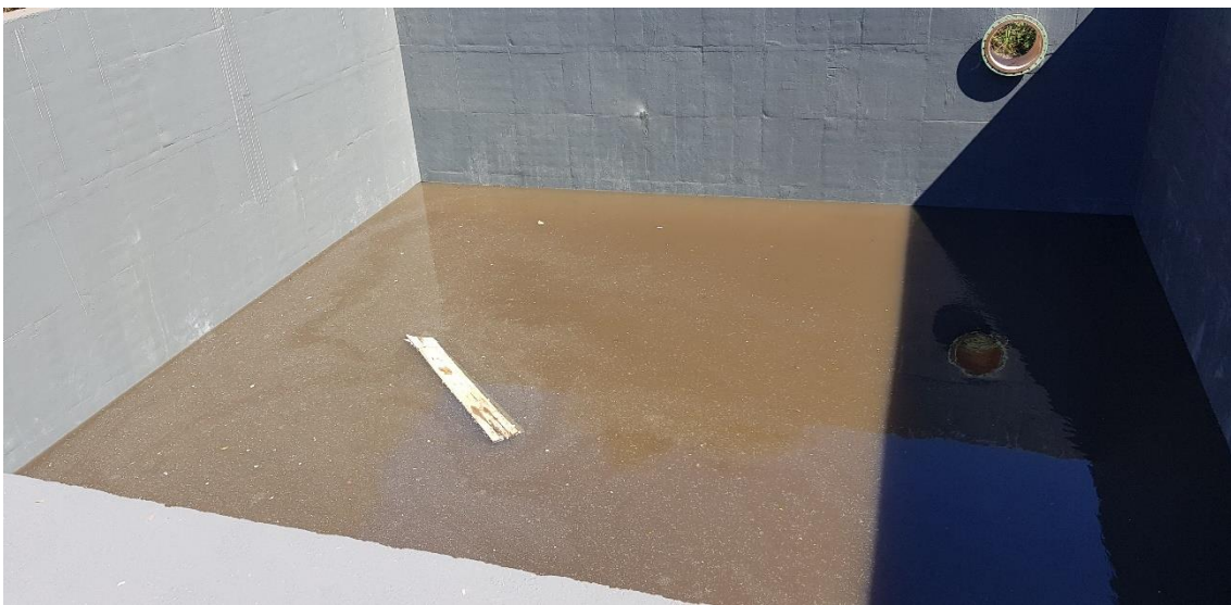
Foto 45 – Tanque em Fase de Teste de Estanqueidade com Águas Residuais da ETE
