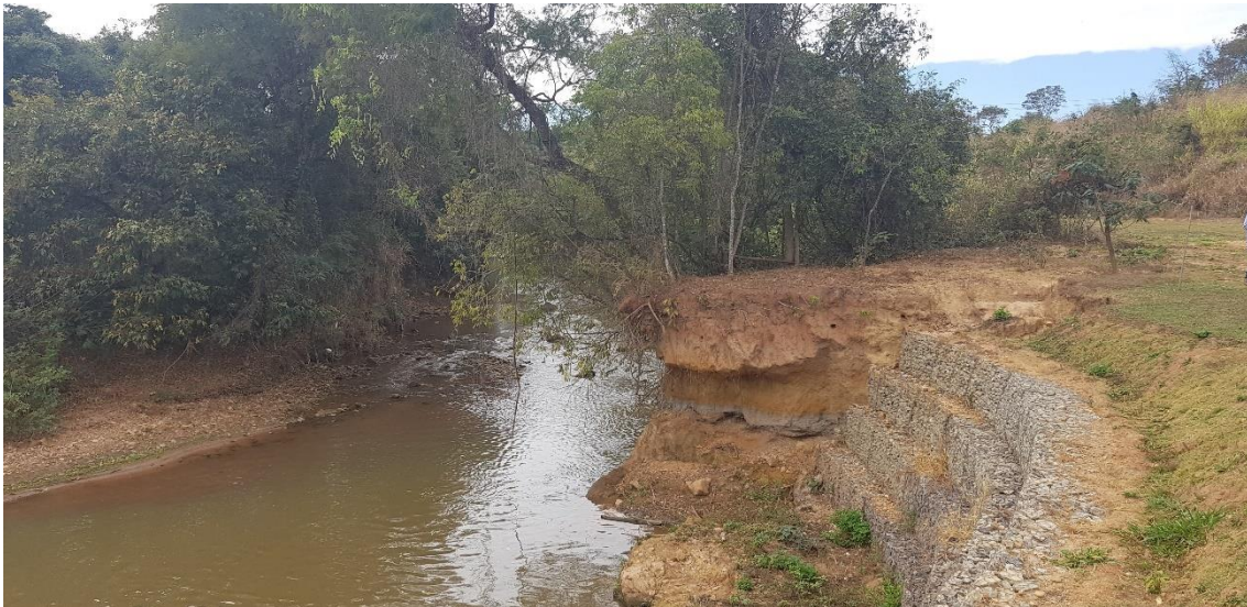
Foto 36 – Vista do rio Melchior a montante do ponto de Lançamento de Efluente, observar proteção de Gabião em margens instáveis.
