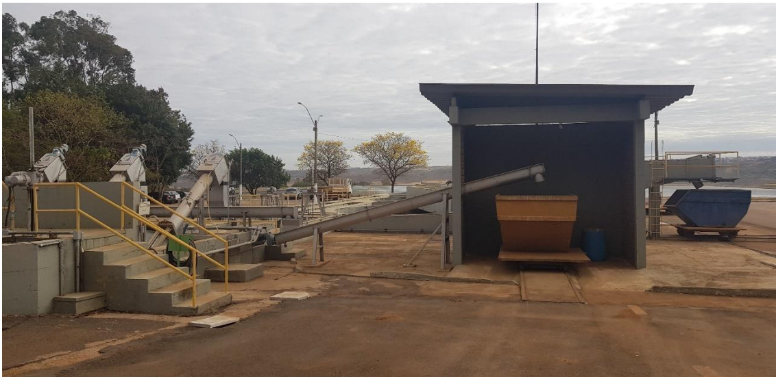
Foto 22 – Remoção de Material fino/Grossoiro do Esgoto (este material é enviado ao aterro sanitário de Brasília)
