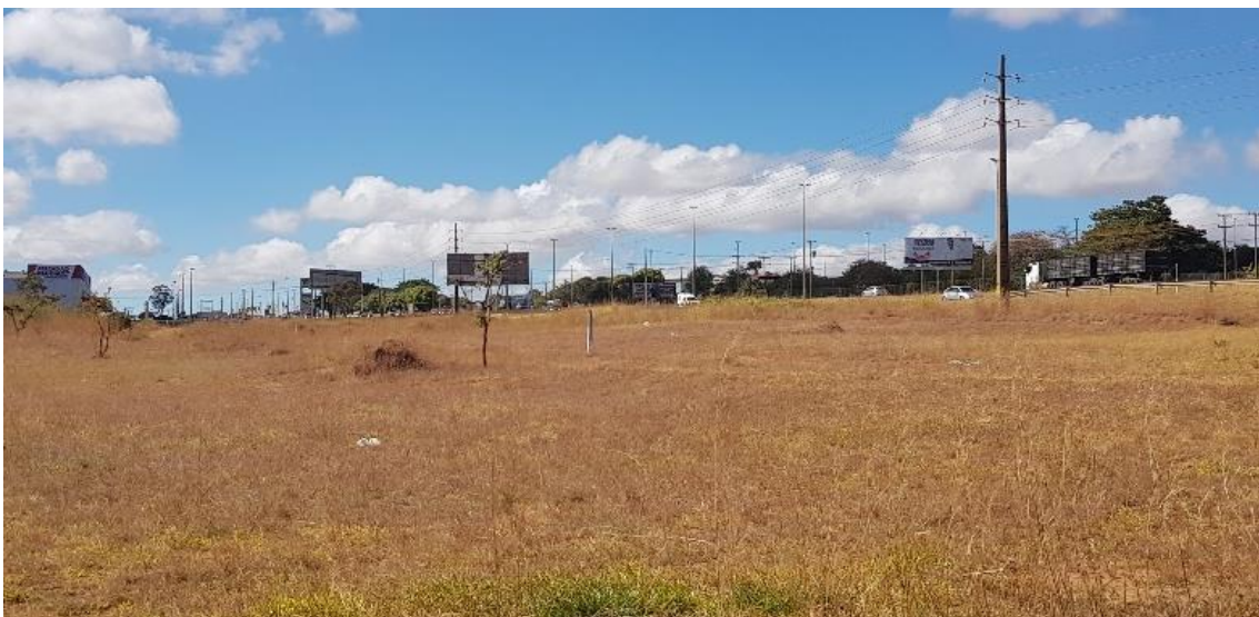
Foto 8 – Vista da Rodovia BR070 a partir da Faixa das Adutoras do Sistema Descoberto
