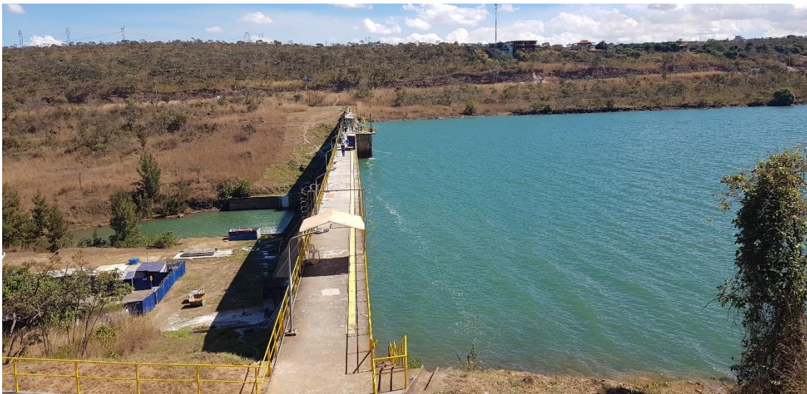
Foto 10 – Barragem Descoberto – Área de Captação do Sistema
