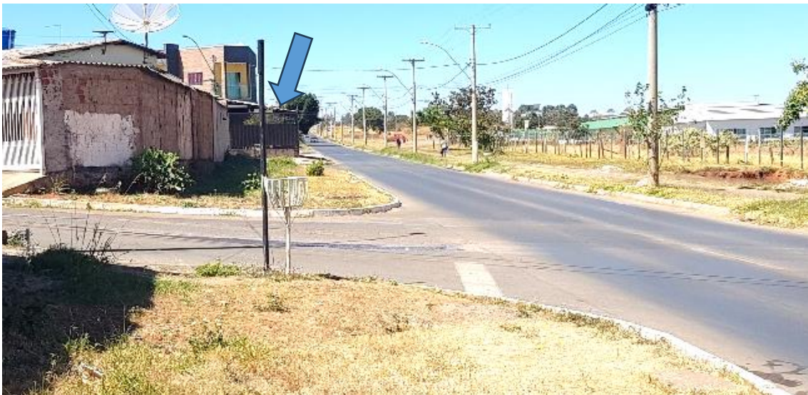
Foto 53 – Avenida Monjolo, destaque para a faixa do Coletor (Trecho 2 – Recanto das Emas), observar a ocupação sobre o coletor
