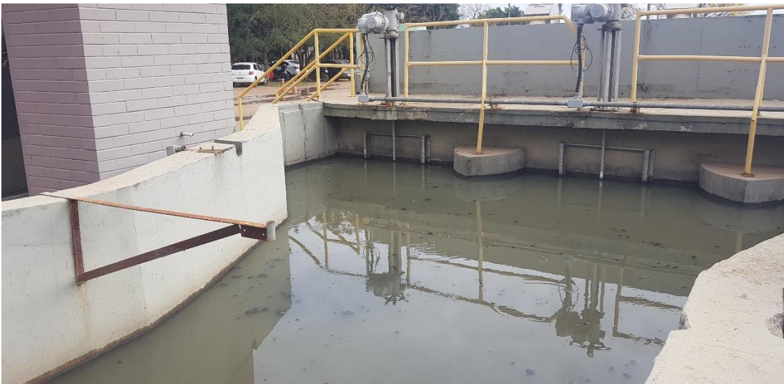
Foto 20 – Chegada do Emissário na ETE Samambaia
