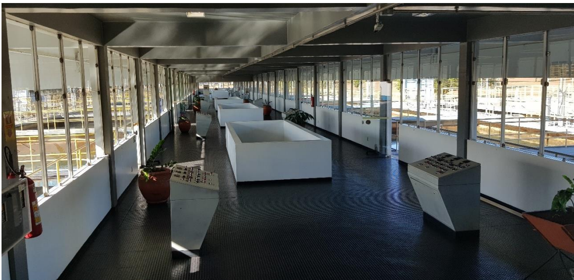
Foto 2 – Mesas de Controles Manuais dos Filtros
