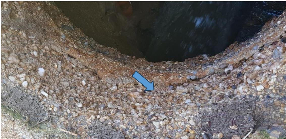
Foto 51 – Material sendo Desagregado em PV – Trecho 1 – Recanto das Emas
