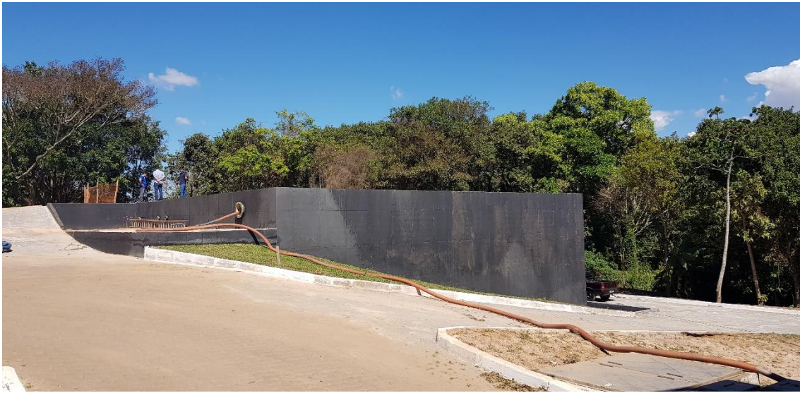
Foto 44 – Tanque de Equalização da Saída de Efluente – Em fase de testes de Estanqueidade
