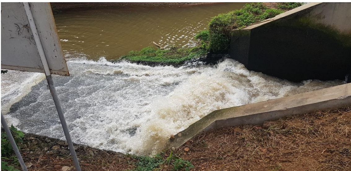
Foto 34 – Lançamento de Efluente no rio Melchior
