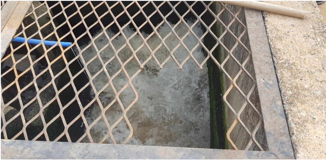
Foto 33 – Saída do Efluente da ETE e encaminhamento ao Emissário para lançamento no Rio Melchior
