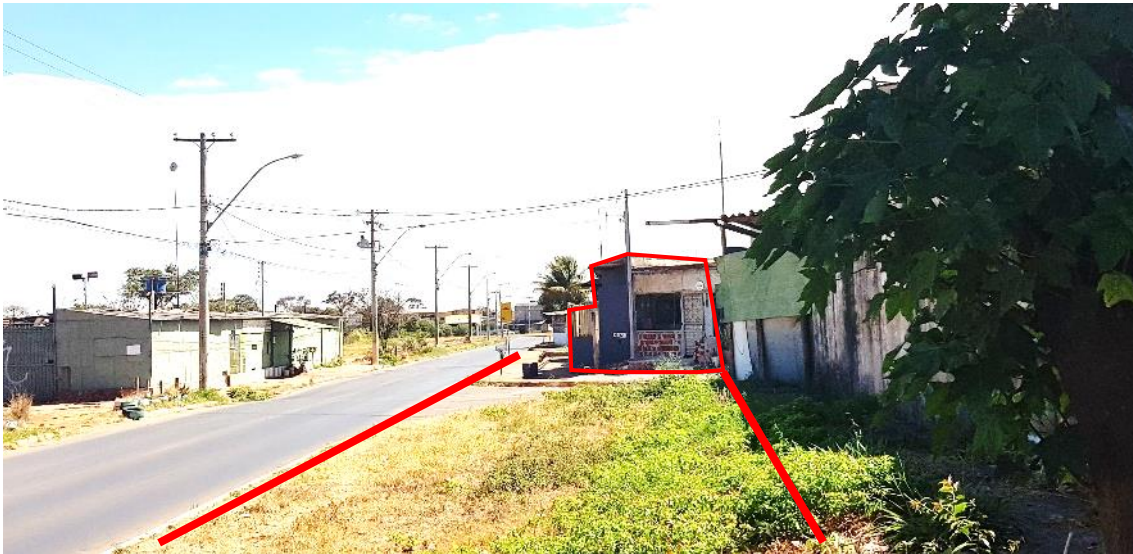
Foto 52 – Avenida Monjolo, destaque para a faixa do Coletor (Trecho 2 – Recanto das Emas), observar a ocupação sobre o coletor.
