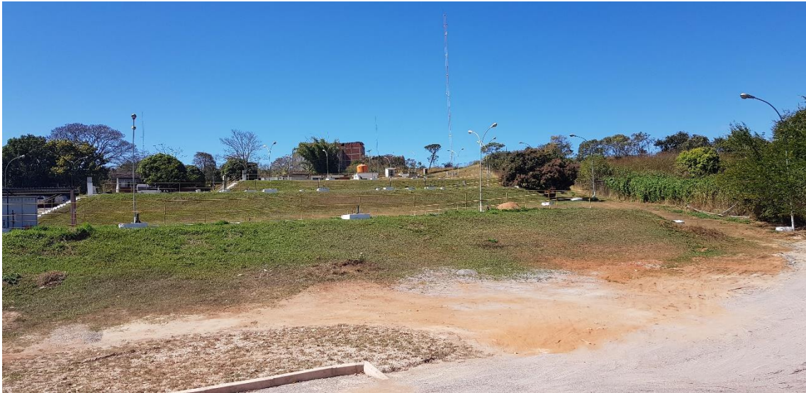
Foto 46 – Vista Geral da ETE Riacho Fundo
