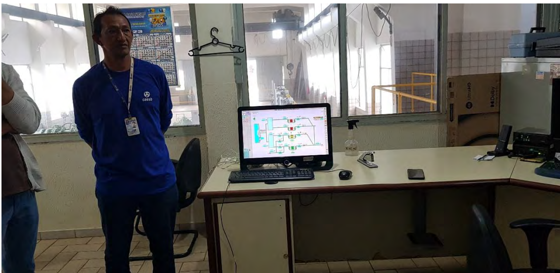
Foto 14 – Sistema de Controle Automatizado do Sistema Torto/Santa Maria
