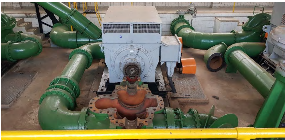
Foto 12 – Bomba em Manutenção – Sistema Torto/Santa Maria
