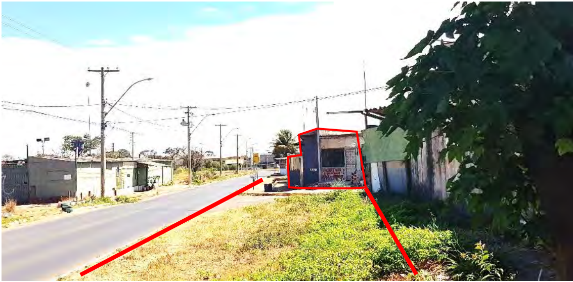
Foto 52 – Avenida Monjolo, destaque para a faixa do Coletor (Trecho 2 – Recanto das Emas), observar a ocupação sobre o coletor.
