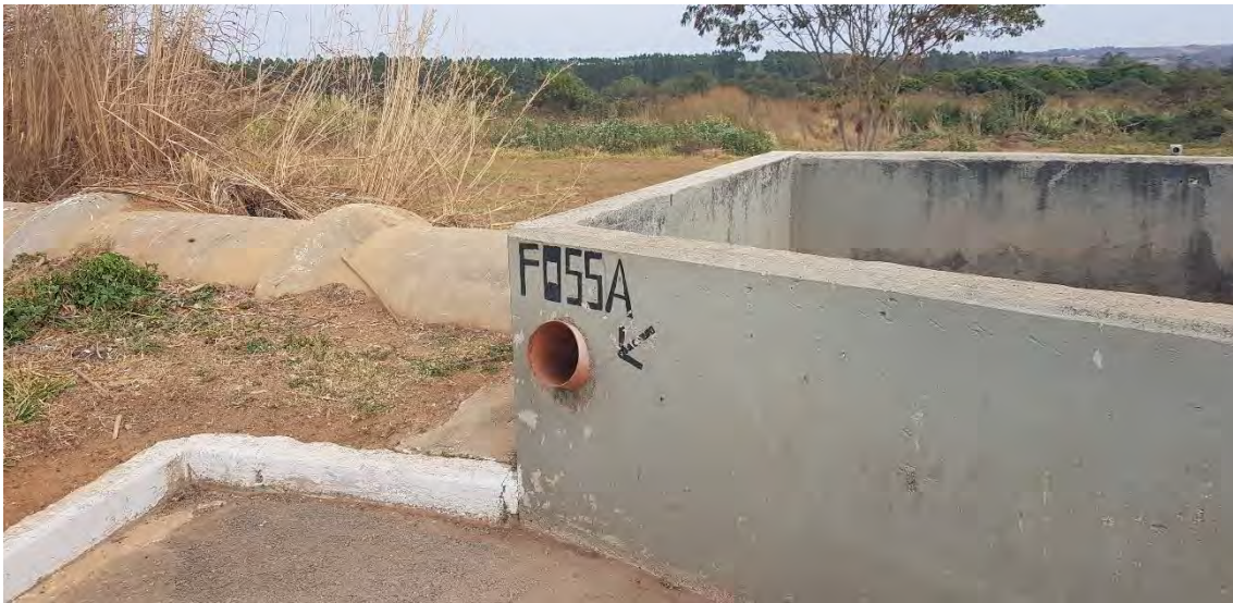
Foto 27 – Entrada Específica para Caminhões Limpa Fossa na ETE Melchior
