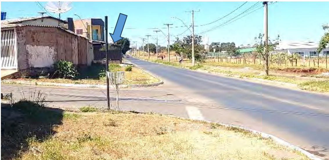
Foto 53 – Avenida Monjolo, destaque para a faixa do Coletor (Trecho 2 – Recanto das Emas), observar a ocupação sobre o coletor
