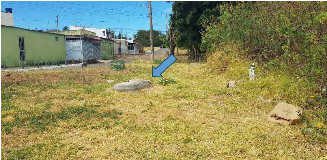
Foto 56 - Poço de Vistoria – PV na Caesb (Trecho 1 – Samambaia)
