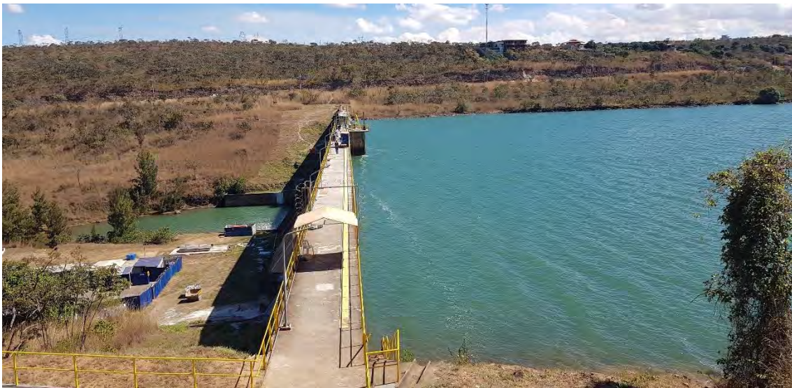
Foto 10 – Barragem Descoberto – Área de Captação do Sistema
