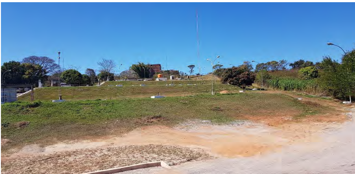
Foto 46 – Vista Geral da ETE Riacho Fundo
