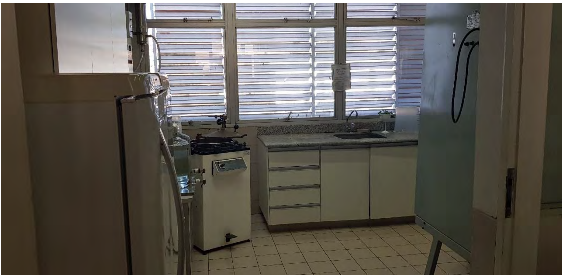
Foto 6 – Área dos Laboratórios da ETA
