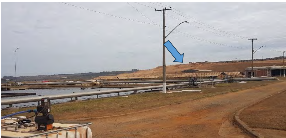
Foto 30 – Vista do Aterro Sanitário de Brasília a partir da ETE Melchior
