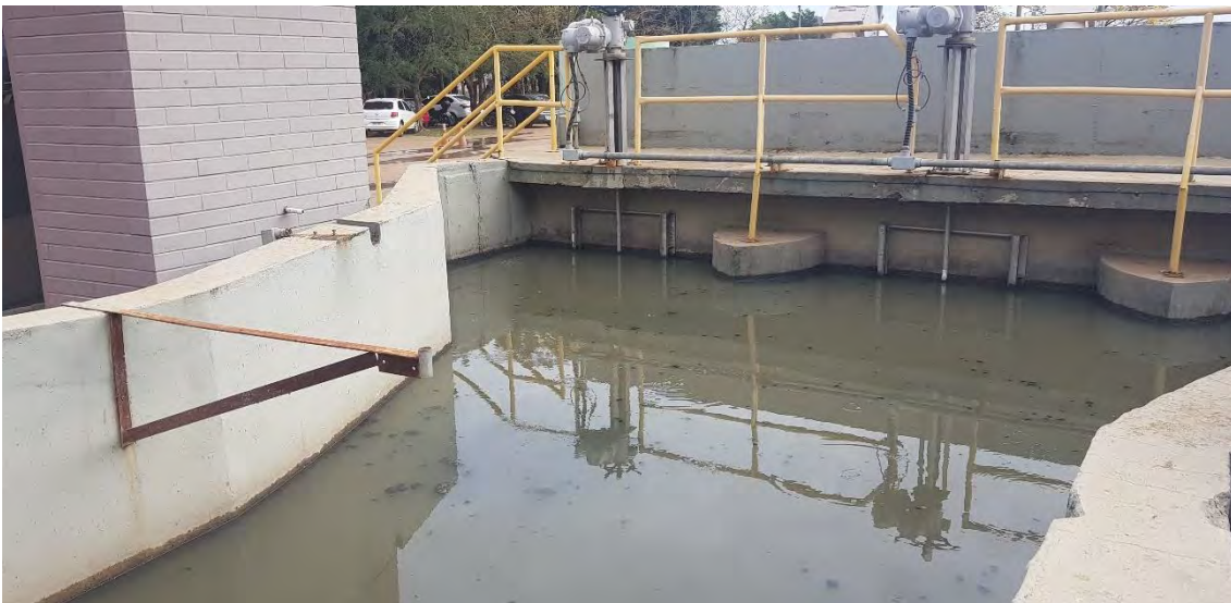
Foto 20 – Chegada do Emissário na ETE Samambaia
