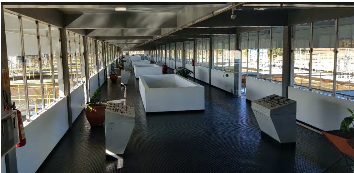
Foto 2 – Mesas de Controles Manuais dos Filtros
