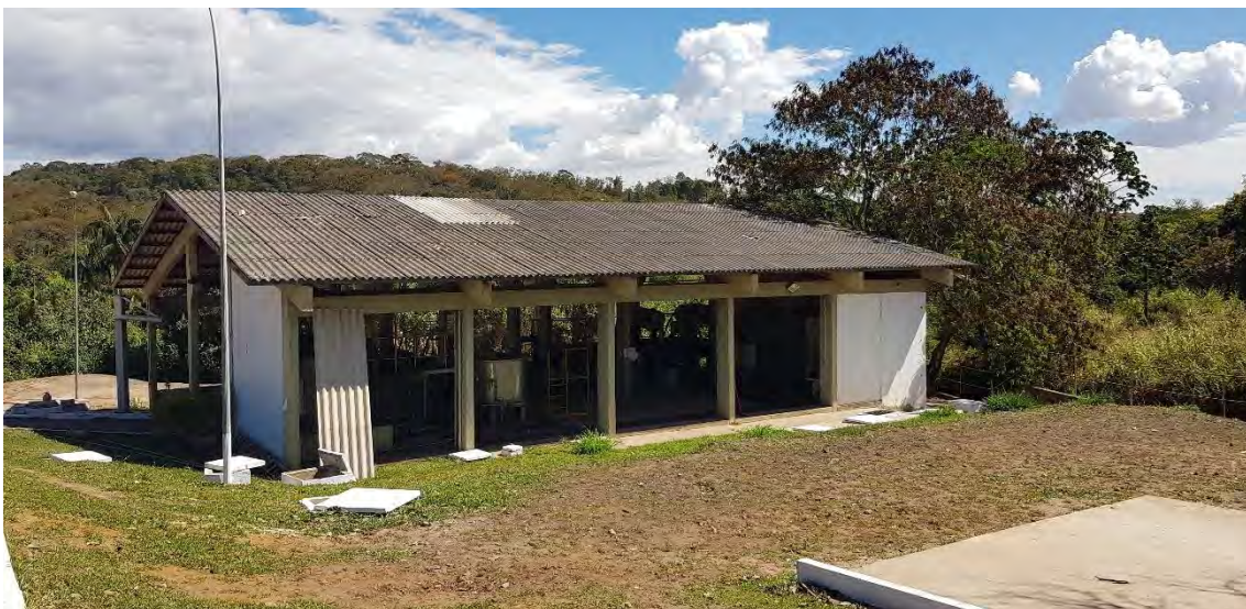
Foto 42 – Área de Centrifugas – Secagem de Lodo
