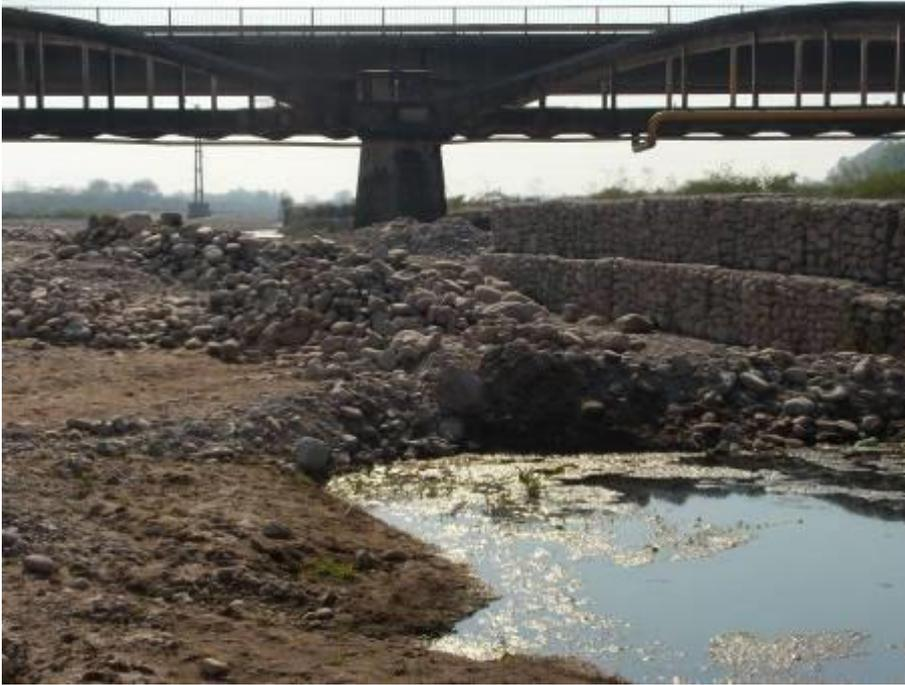
Foto 23 Vista de los gaviones aguas arriba del puente
