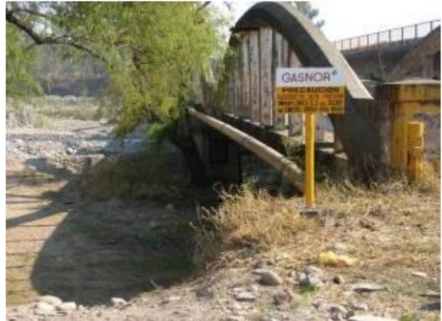
Foto 39 Cruce del gasoducto utilizando el antiguo puente sobre el río Grande
