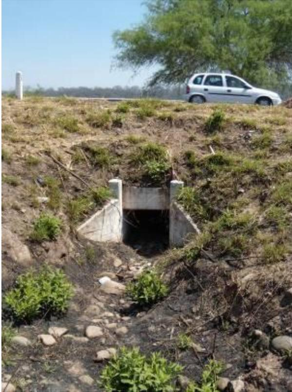
Foto 65 Alcantarilla de 1 m de luz en progresiva Km. 18
