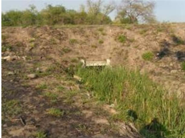
Foto 58 Alcantarilla que conduce los caudales provenientes de las vertientes
