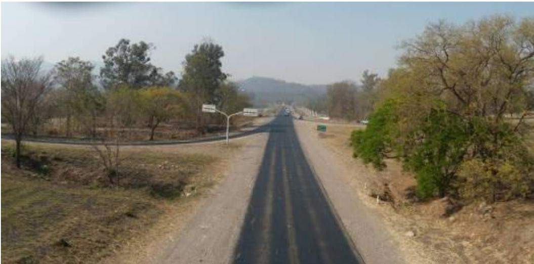
Foto 24 Vista desde el puente de la RP-56 hacia el puente sobre el río Grande. Se observa la carencia de trochas de aceleración y frenado
