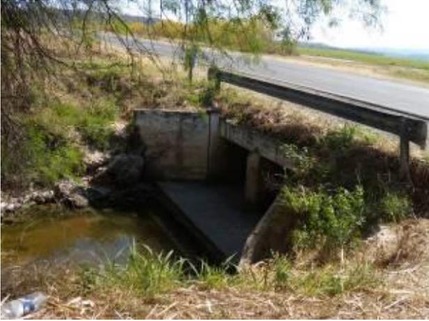
Foto 49 Vista de la salida de la alcantarilla de cruce. Se observa erosión a corregir
