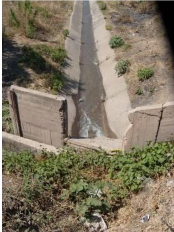
Foto 74 Vista lateral del mismo partidor. Canal paralelo al trazado.
