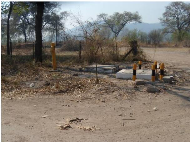
Foto 9 Cámaras del gasoducto en cruce con RP-56
