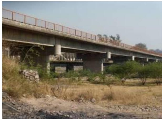
Foto 19 Vista del costado a ensanchar del puente sobre el río Grande. Gaviones
