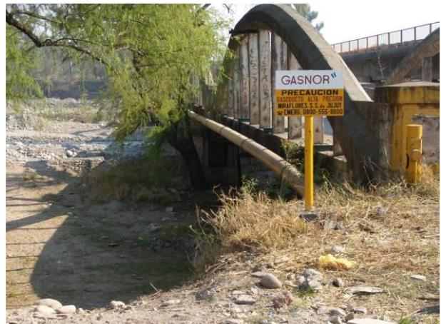
Foto 8 Cruce del gasoducto utilizando el antiguo puente sobre el río Grande
