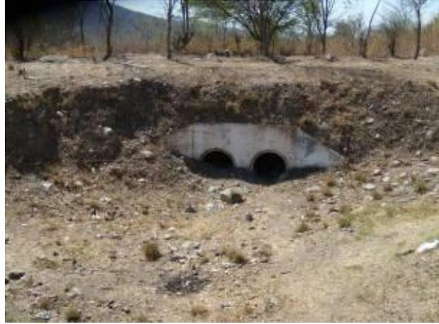
Foto 76 Cruce con dos caños, por debajo de la acequia revestida paralela al trazado.
