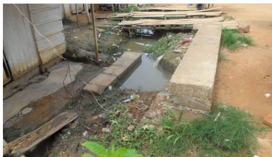
Vue des contraintes d'écoulement induites par l'enherbement des caniveaux et leur encombrement par les déchets
