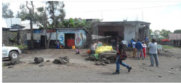
Vue des installations le long de la voie à réhabiliter
