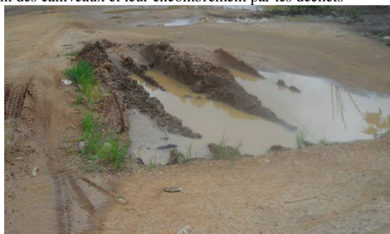
Vue de l'état de la route
