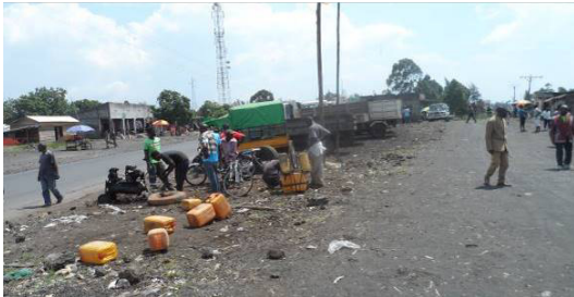
Vue de l'insalubrité le long de la voie à réhabiliter
