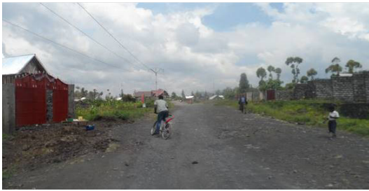
Vue de l'état sableux de la voie à réhabiliter
