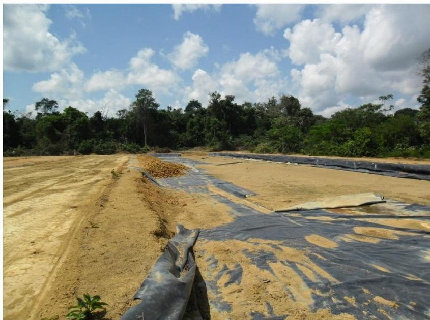
**Figura 57 – Processo construtivo das Células do Aterro: Colocação de manta para impermeabilização do fundo.**
