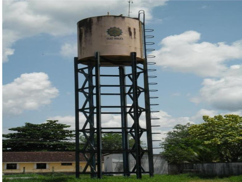
**Figura 43 – Reservatório de Compensação/Assimilação (Desativado).**
