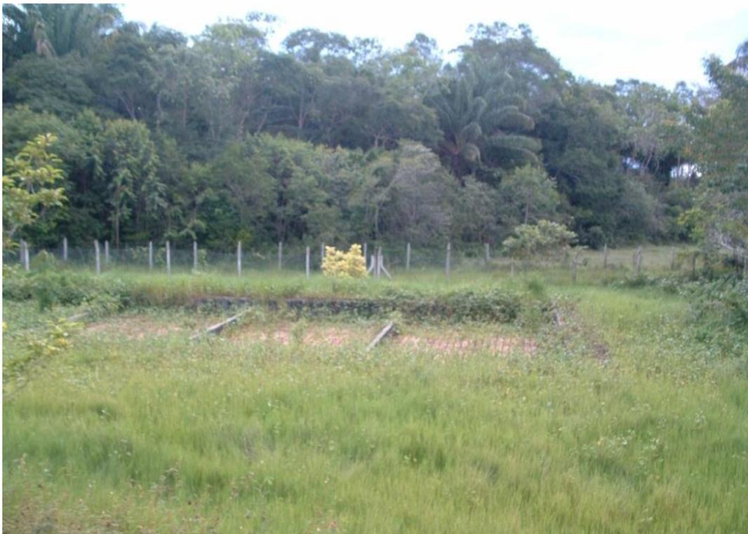
**Figura 30 – Leito de secagem (sem utilização).**
