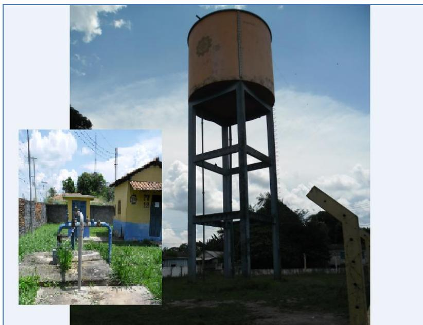
Figura 39 – Reservatório Elevado de 227m<sup>3</sup> ao Poço PT-12. Bairro de Maresia.
