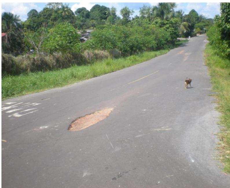
Figura 65 – Recomposição Asfáltica.
