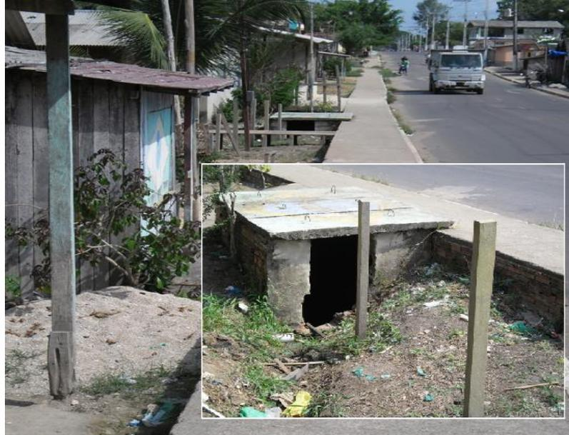
**Figura 62 – Casas construídas abaixo da cota de coleta de drenagem.**
