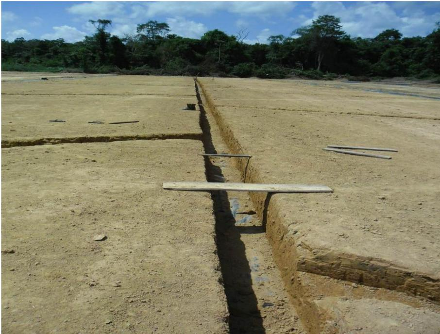
**Figura 58 – Processo construtivo das células do Aterro: Preparação do solo para a instalação dos dutos de drenagem.**
