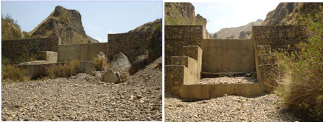
Figura 5. Obras existentes. Izq. necesita ser rehabilitada. Der. Obra en buen estado
