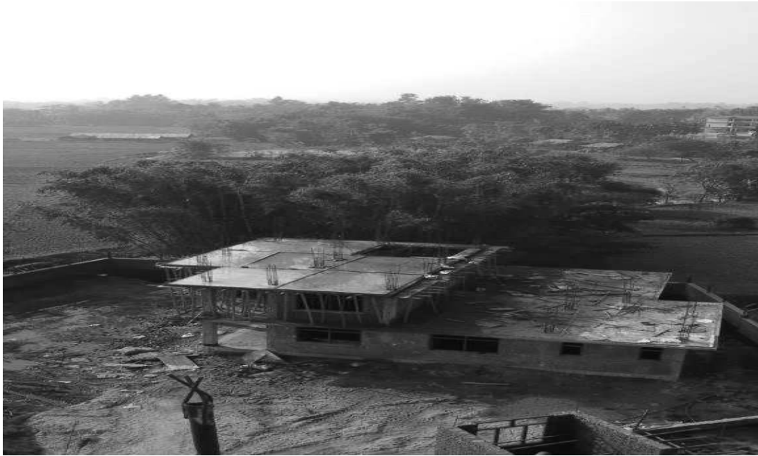
OHT 450 m3 and Generator cum Guard House (Charali)
