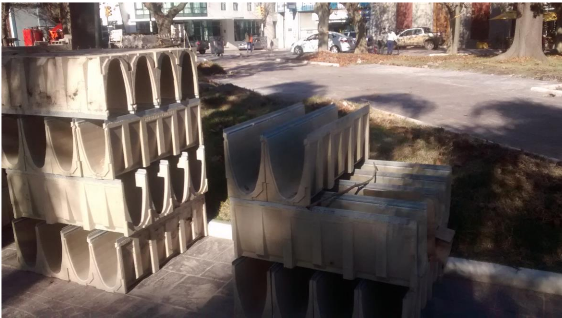
Figura 5. Sistema de drenaje de la plaza previo a su colocación
