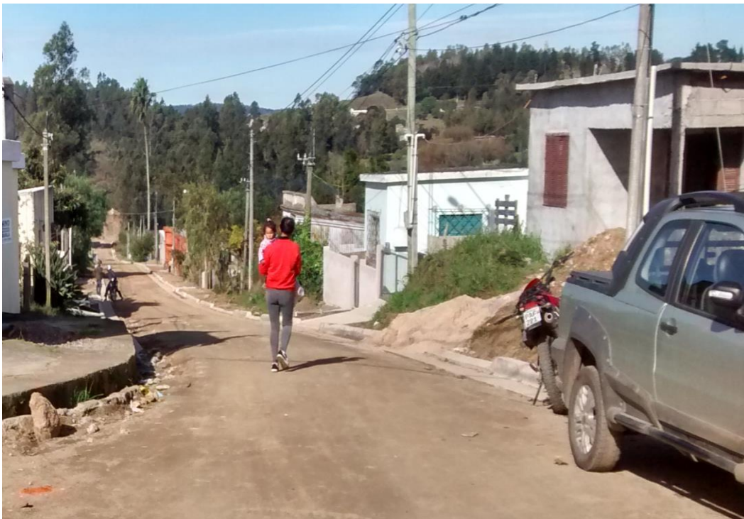
Figura 13. Obras pluviales de la intendencia, complementarias a las de la Avenida Barrios Amorin
