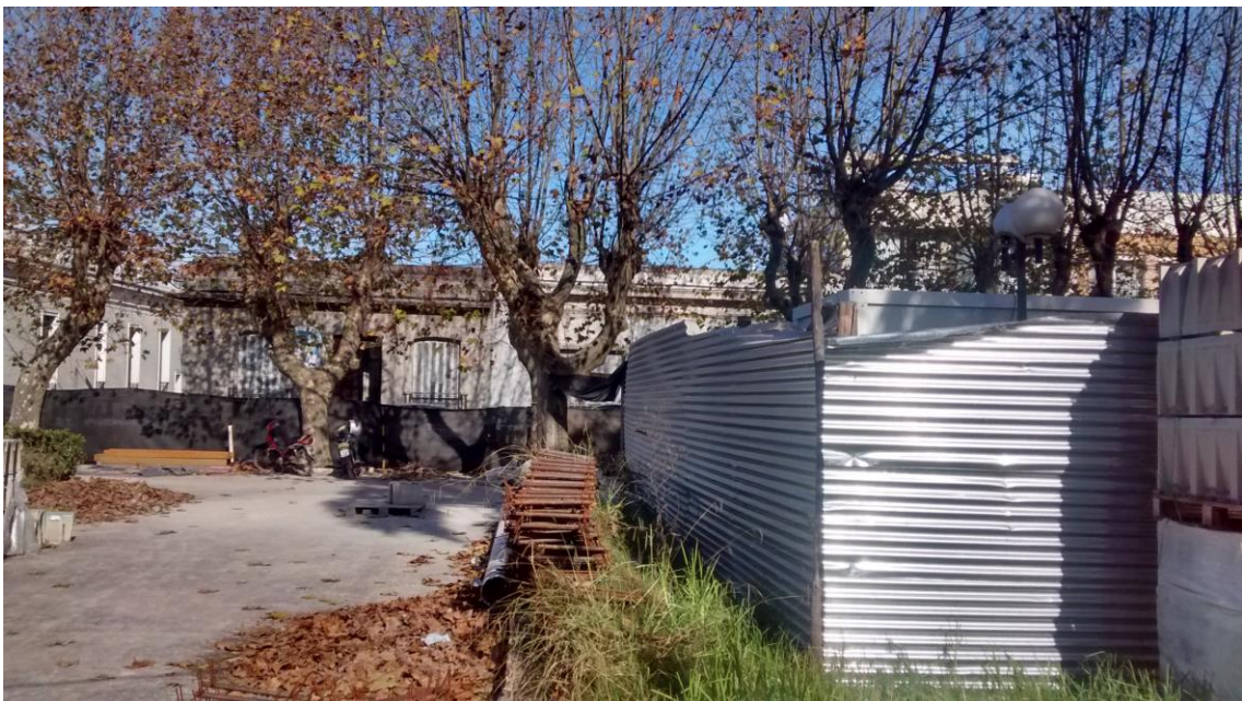
Figura 7. Separación física del obrador de la plaza Libertad
