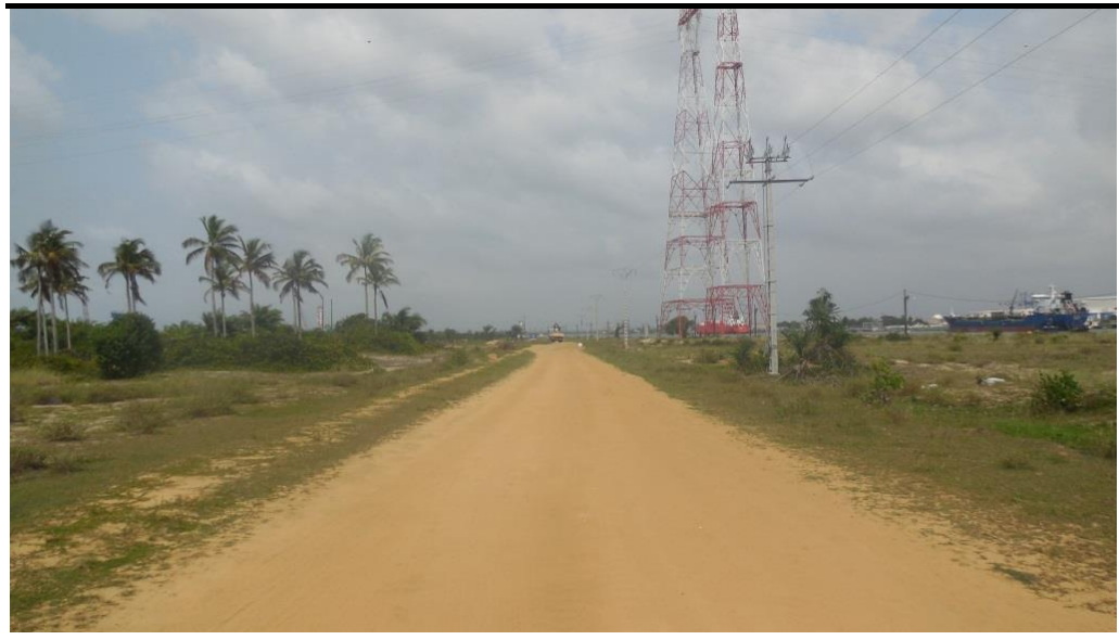
Figure 3.6 Piste existante le long du canal de Vridi
