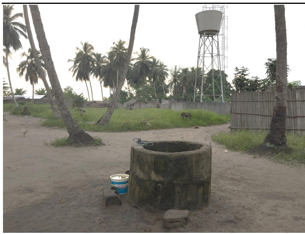
Figure 6.36 Vue du château d'eau à Taboth
