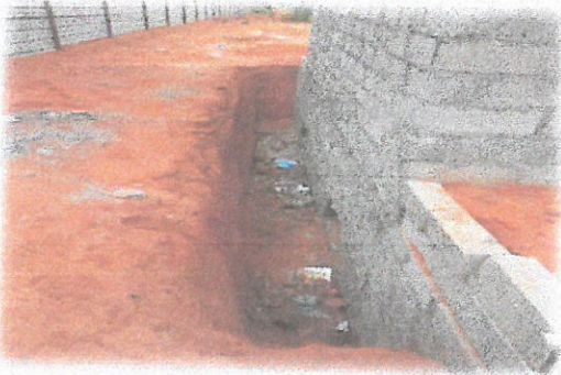
Foto 7: Estado da parte traseira dos sanitários
