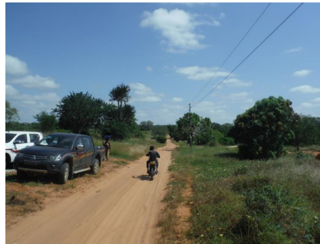
Imagem 2: Trajecto da Tubaria entre a Tomada de Água e o Local das Instalações Bitá.
