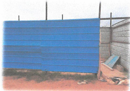
Foto 4: Entrada do balneário no local da obra
