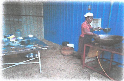
Foto 13: Posicionamento incorrecto da mangueira de gás
