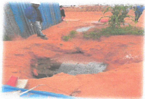
Foto 8: Esgoto da cozinha de serviço dos trabalhadores nacionais
