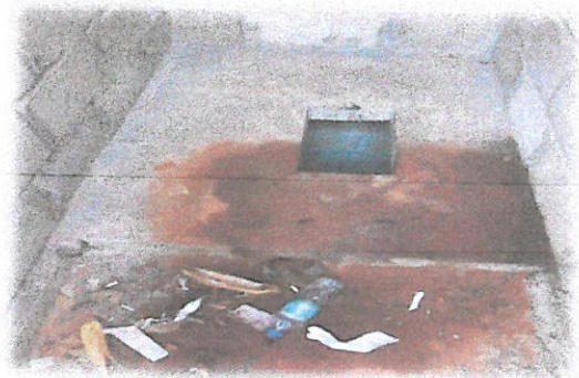
Foto 5: interior do sanitário dos trabalhadores nacionais
