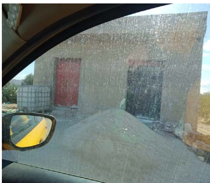
Construction dans l'emprise du projet
