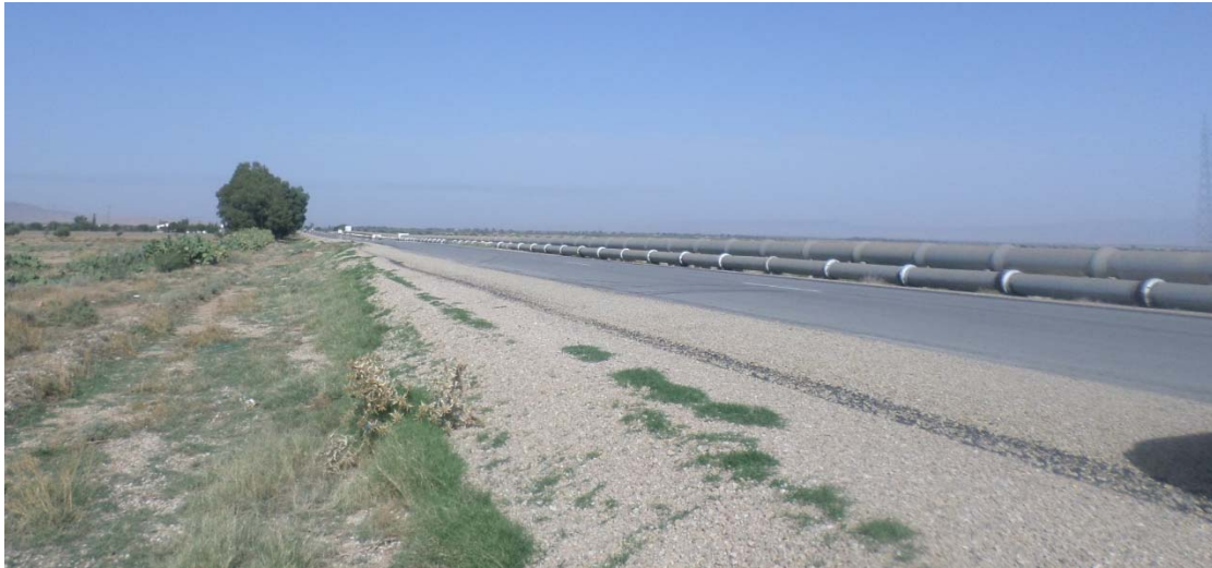
Figure 7 : Les conduites SONEDE longeant la RN13
