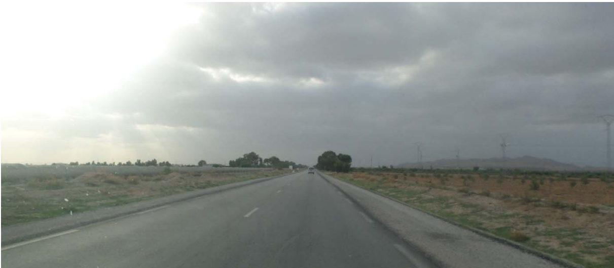
Figure 6 : Traversée du Garaât Al Akarich
