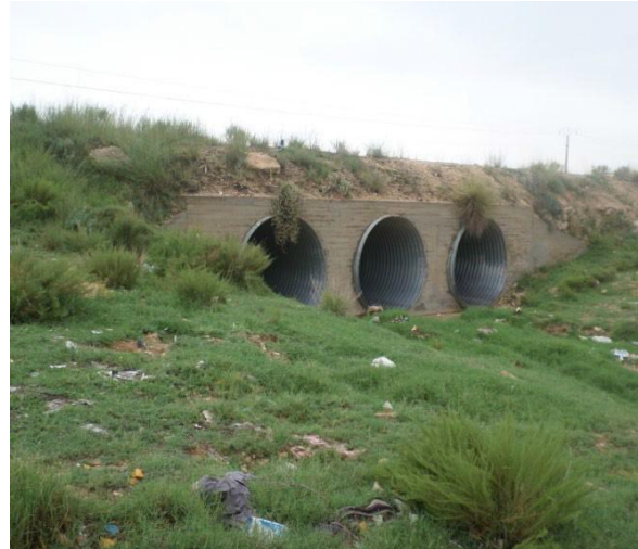
Figure 32. 3 Buses Ø 2500 sur O.Ad-Difla
