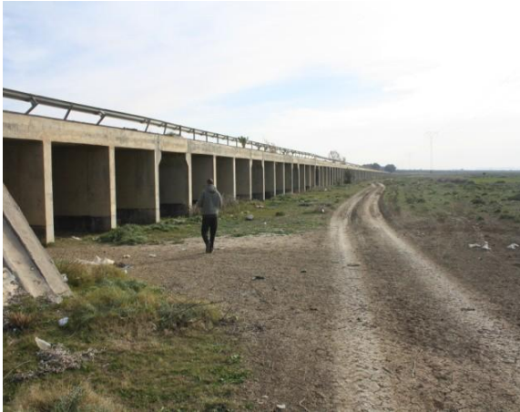
Figure 29. Ouvrage sur Oued Enagatha
