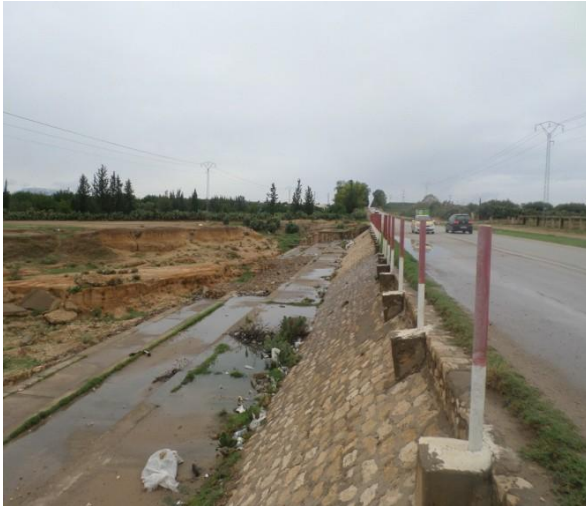
Figure 31. Ouvrage Cassis sur l'oued ash shrayi
