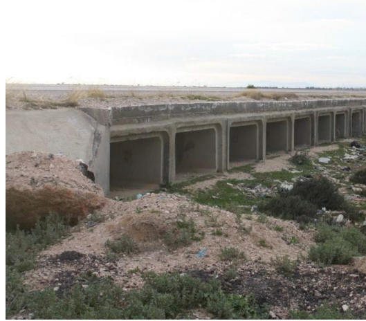
Figure 30. Ouvrage 15 x (2x1) _ Garaet Akarich
