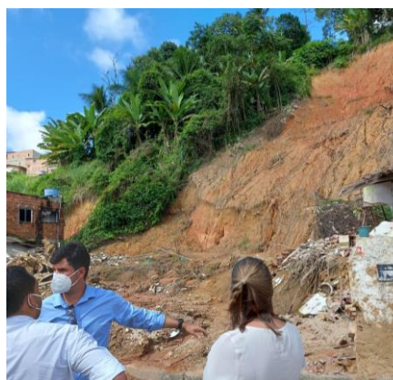
Foto 6 – Deslizamento de encosta às margens da Rua Pico da Bandeira
