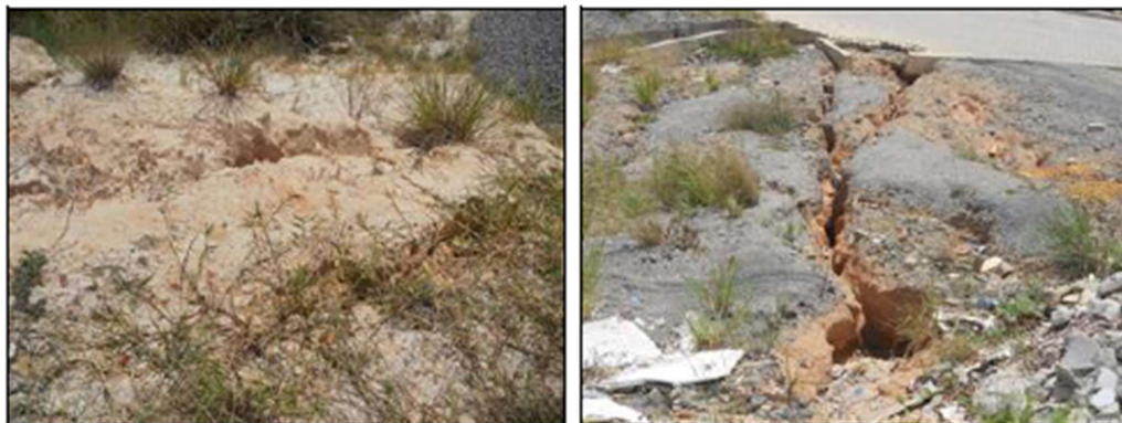
Figura 88 – Exemplos de voçoroca existente no bairro do Jordão
