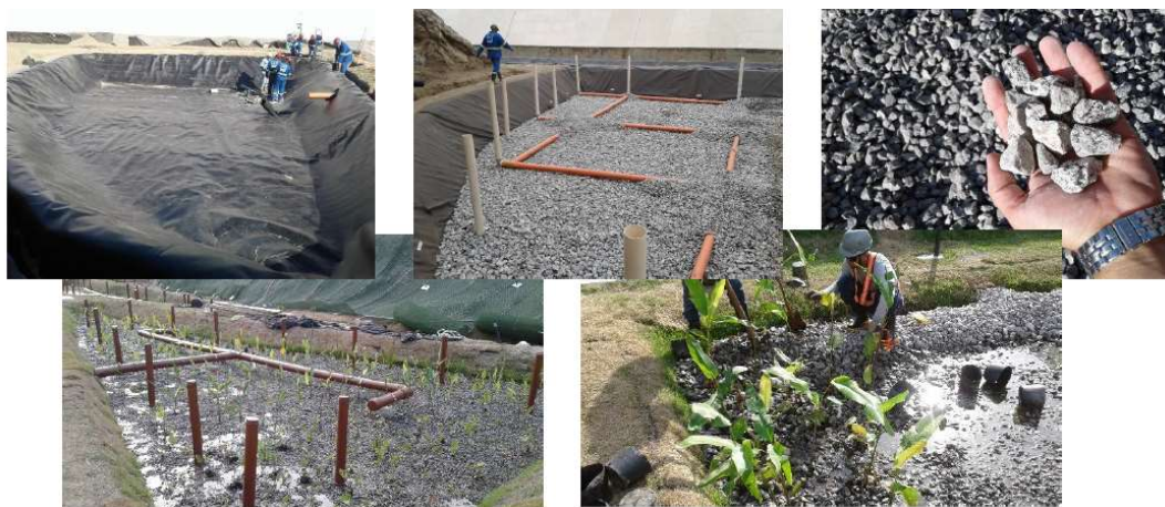
Foto 16 – Área com instalação de jardim filtrante
