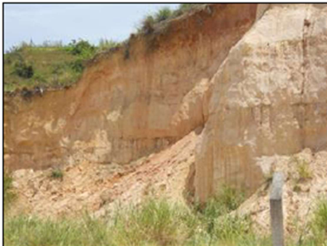
Figura 85 - Pequeno deslizamento na área de estudo
