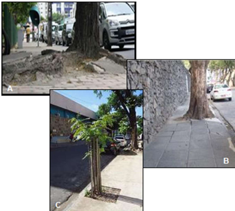
Figura 40 - Exemplos de condições de plantio de espécies arbóreas de grande porte em calçadas das ruas do Recife
