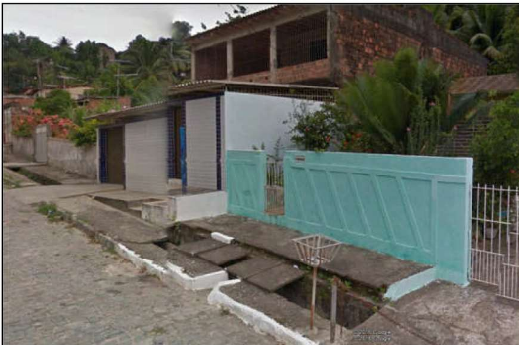
Foto 2 – Canaleta existente na Rua Paulo Biase
