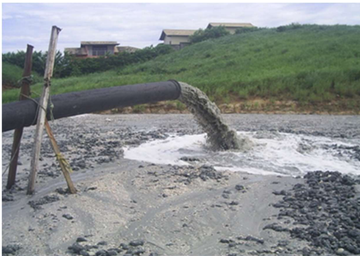
Foto 4 – Exemplo de Lançamento em Diques de Contenção
