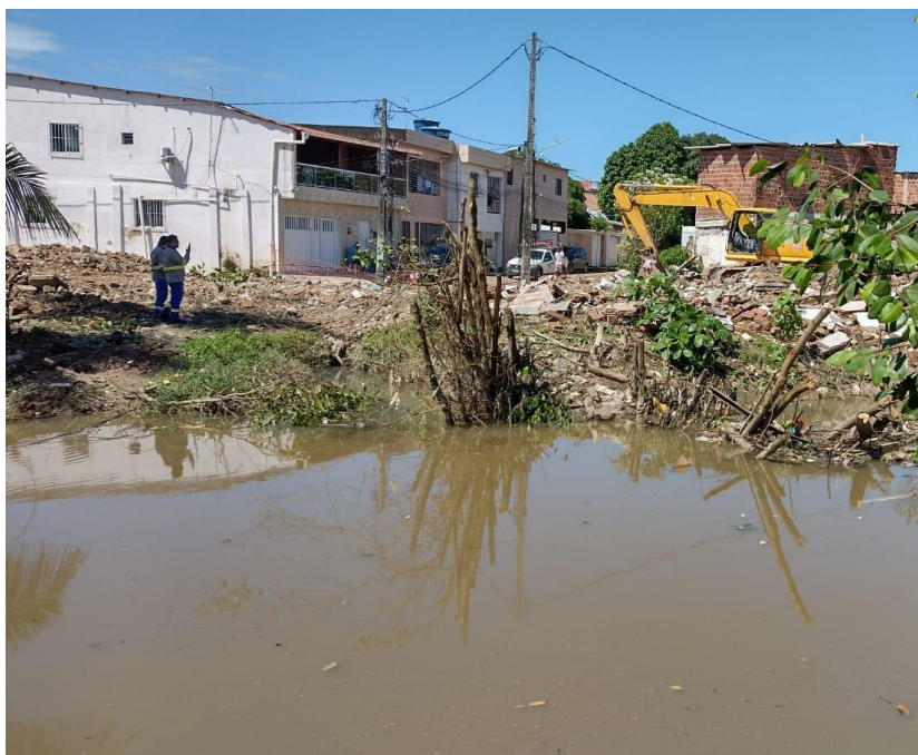
Río Tejepió – Áreas afectadas por desbordamiento em mayo 2022
