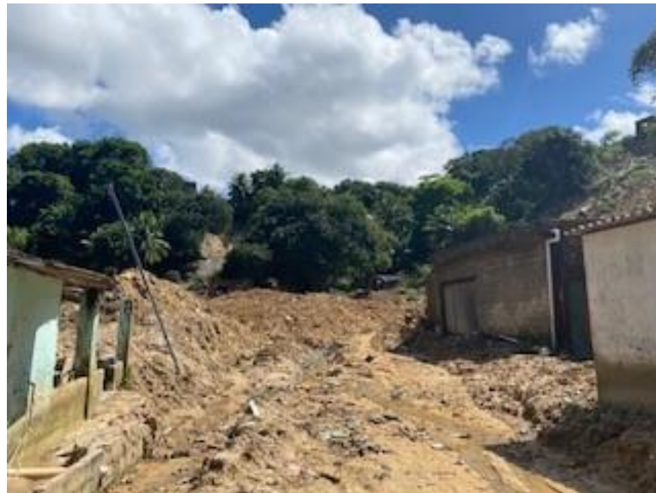
Viviendas afectadas por el deslizamiento de mayo 2022
