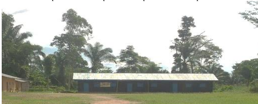
Photo 1 : Ecole primaire du campement de Upende construite par le 8 ème CEPAC
