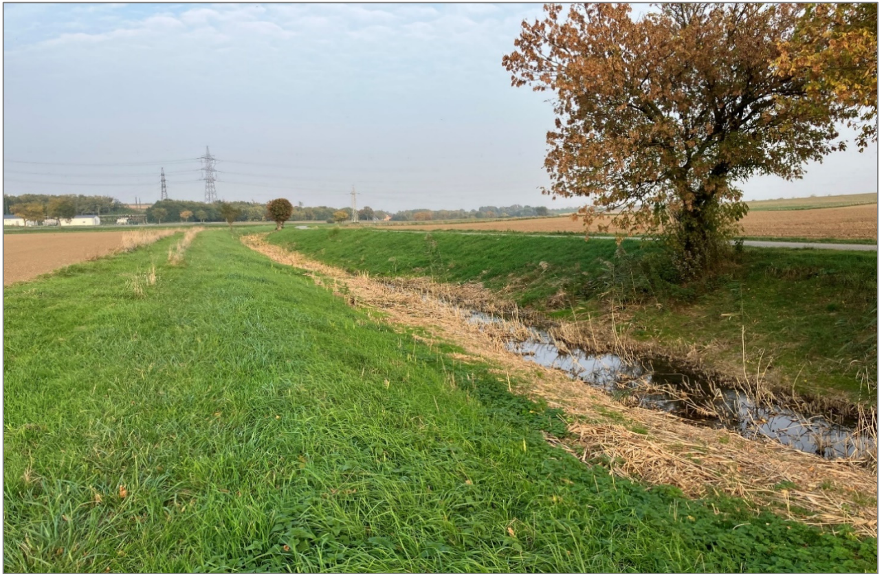
Abbildung 15: Gewässerquerung 11 Sulzbach (Bohrung)
