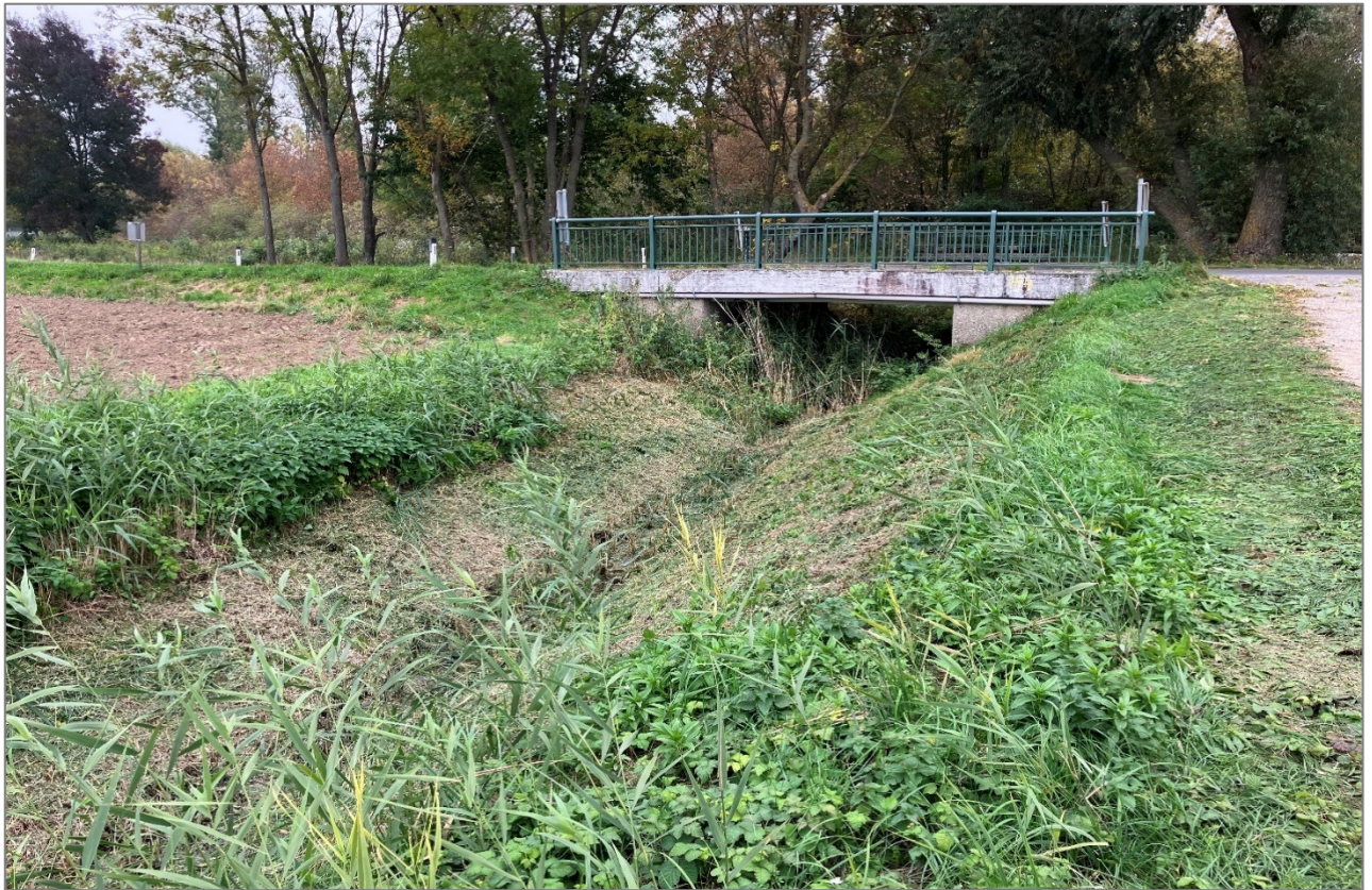
Abbildung 21: Gewässerquerung 23 -Göstingbach (Bohrung)
