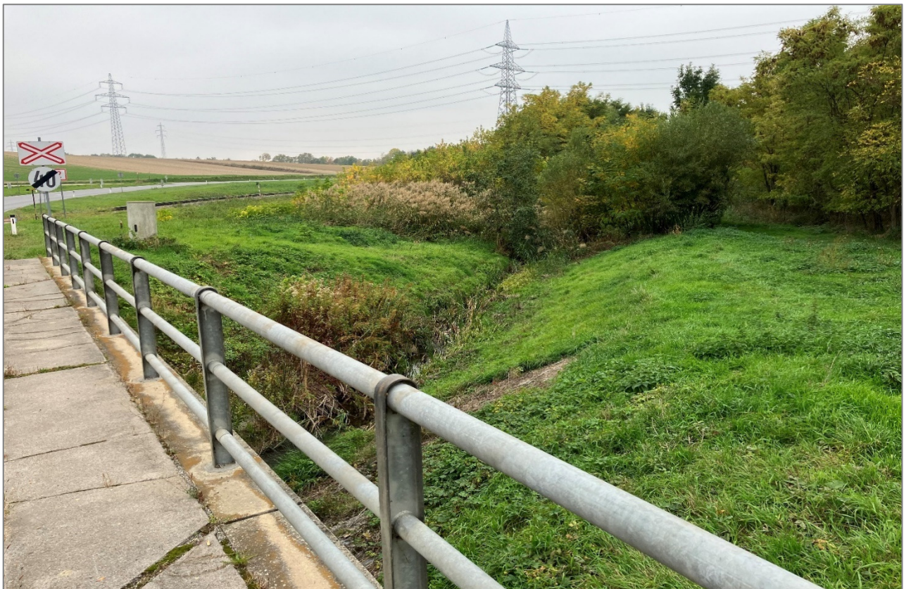
Abbildung 20: Gewässerquerung 21p – Zistersdorfer Bach (Bohrung)
