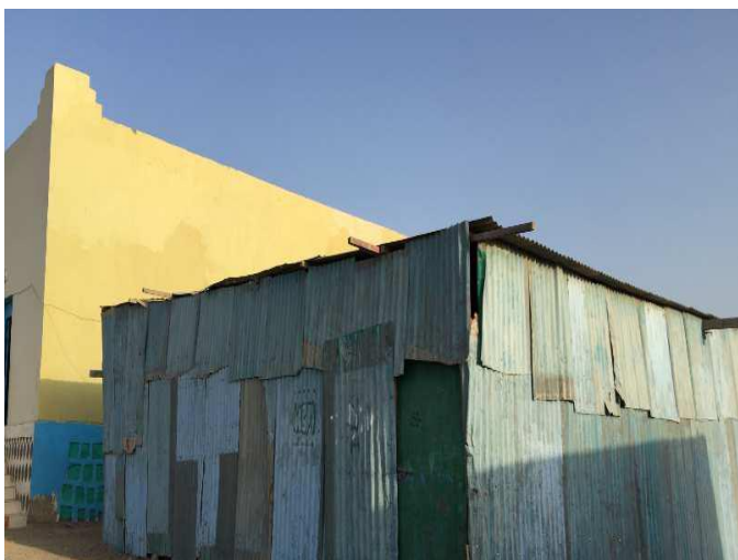
photo 5: espace de stockage actuel de la mosquée et l'emplacement future du poste transformation n2
