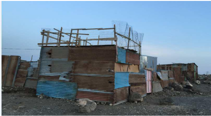
photos 1: vue extérieur d'une habitation en tôle et bois dans le quartier de Layabley
