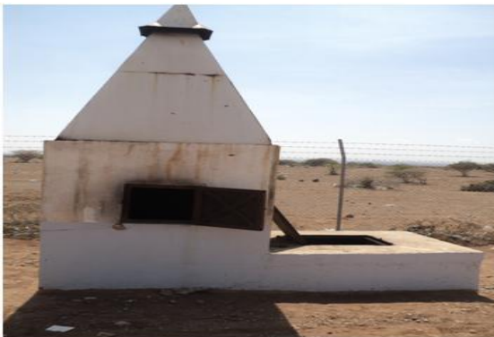
L'incinérateur (à gauche) et la fosse septique du poste de santé (à droite)
