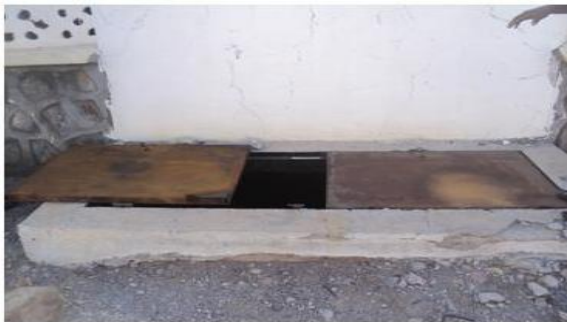
L'incinérateur et ses portes défectueuses
