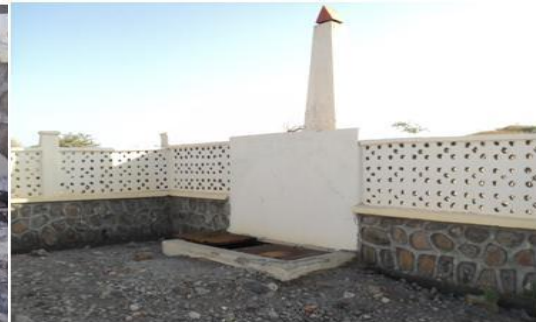
L'incinérateur et ses portes défectueuses
