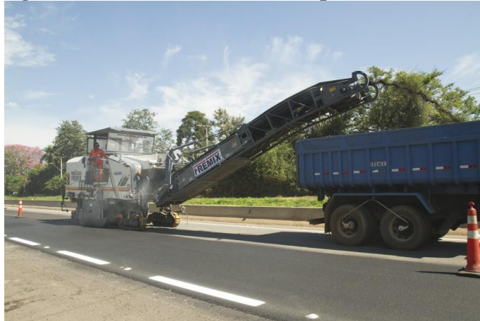
Fotografía 2-1 Fresado de un pavimento asfáltico
