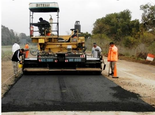
Fotografía 2-2 Extensión carpeta asfáltica
