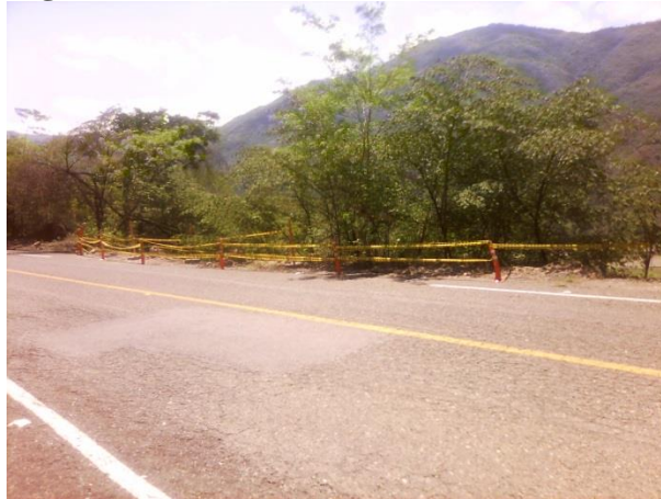
Fotografía 2-12 PK 40 + 750 Socavación vial
