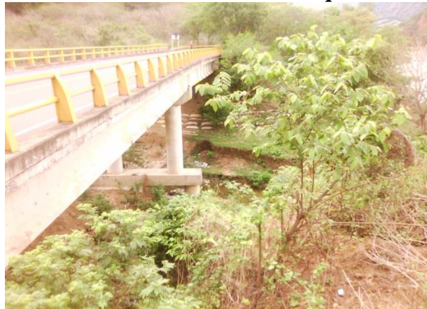
Fotografía 2-13 PK 43 + 870 Puente quebrada La Palma
