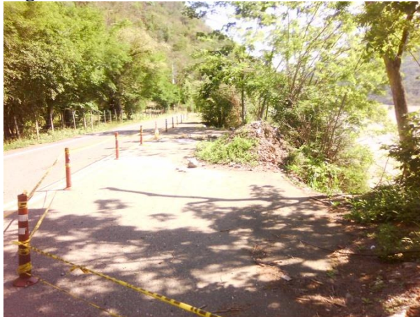
Fotografía 2-15 PK 46 + 500 Socavación vial
