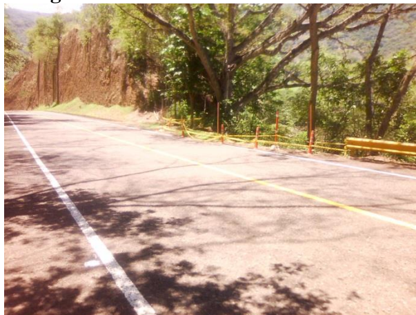
Fotografía 2-9. PK 37 + 550 Socavación vial
