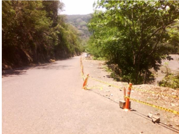
Fotografía 2-8 PK 37 + 150 Socavación vial
