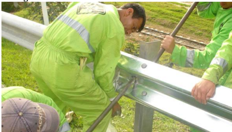
Fotografía 2-21 Instalación defensas metálicas viales
