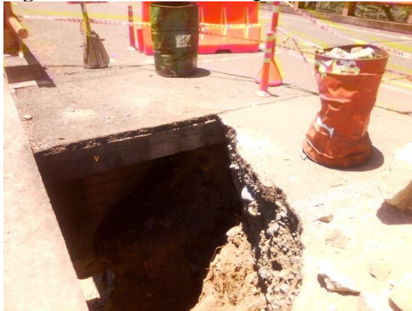
Fotografía 2-7 Puente Quebrada Sabaletica
