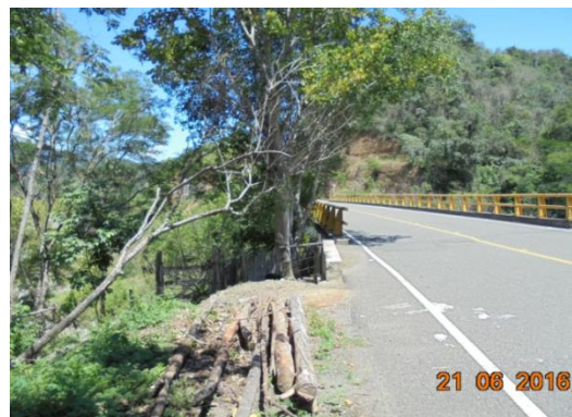
Fotografía 3-54 Puente sobre vía entre Santa Fe de Antioquia y Bolombolo
