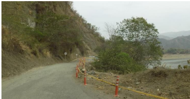
Fotografía 4-23 Pérdida de estabilidad en la vía en el tramo Bolombolo-Santa Fe
