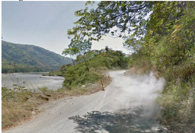
Fotografía 2-10 PK 40 + 100 Socavación vial
