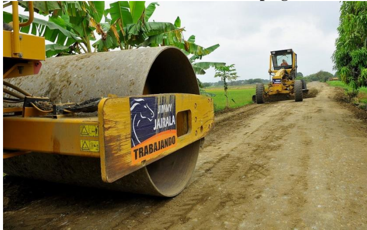
Fotografía 2-4 Reconformación capa granular en vía.
