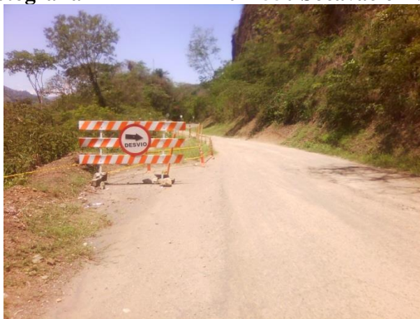
Fotografía 2-11 PK 40 + 550 Socavación vial
