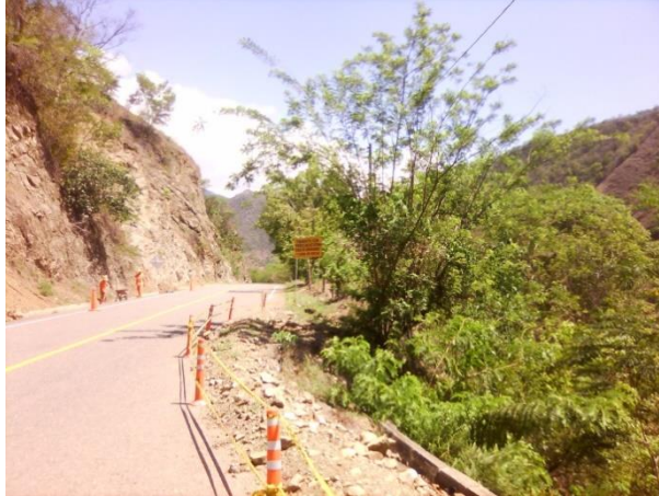
Fotografía 2-14 PK 46 + 500 Socavación vial
