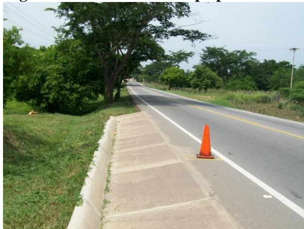
Fotografía 2-17 Cuneta tipo para carreteras
