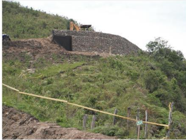
Fotografía 2-5 Muro de contención en gaviones
