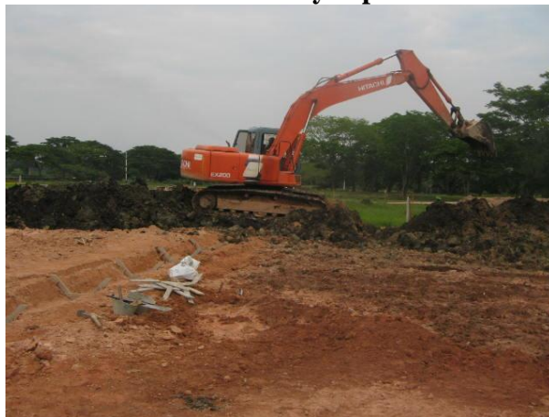
Fotografía 2-16 Demolición y explanación en carreteras
