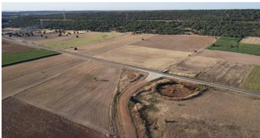
Figura 7.26 Laguna de La Mora y entorno de la Subestación Tábara
