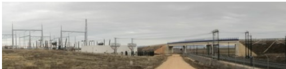
Figura 7.31 Subestación Tábara y vía AVE
