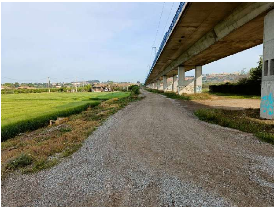
Aspecte del punt P11 pel cantó sud sota la línia de l'AVE
