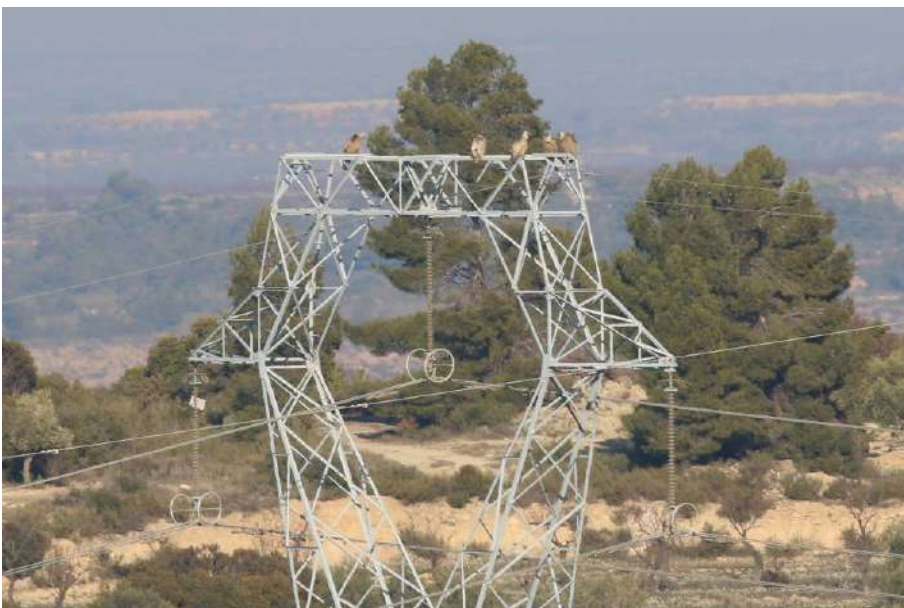
Voltors aturats sobre una torre d'alta tensió a la zona de la Granadella el 18-2-2022 (V. Pedrocchi)
