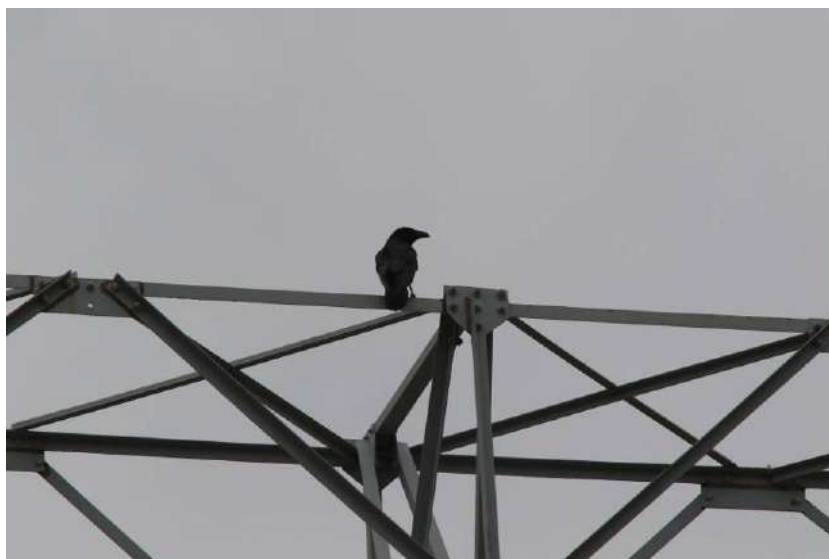
Corb sobre torre elèctrica a la comarca de Les Garrigues el 23-5-2021 (V. Pedrocchi)
