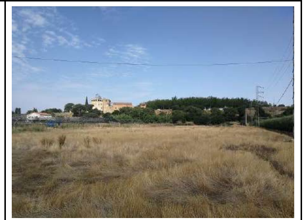
Foto 22. Zona on final del tram soterrat i inici del tram final de la línia aèria.
