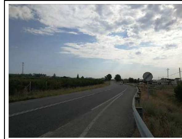
Foto 19. Tram central de la línia soterrada paral·lel a la N-II.
