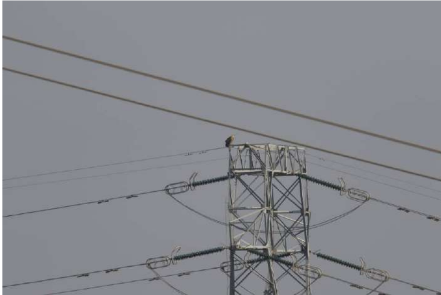
Voltor sobre una torre a la comarca de les Garrigues, on es pot observar les dimensions de la torre i els aïllants respecte el voltor, que eliminen qualsevol possibilitat de risc d'electrocució (V. Pedrocchi)
