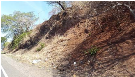
Talud sobre suelo, 13°25'5"N/87°23'12"O.
