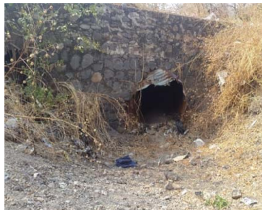
Extremo opuesto de la Falla. Observese el estado de la tubería metálica corrugada.
