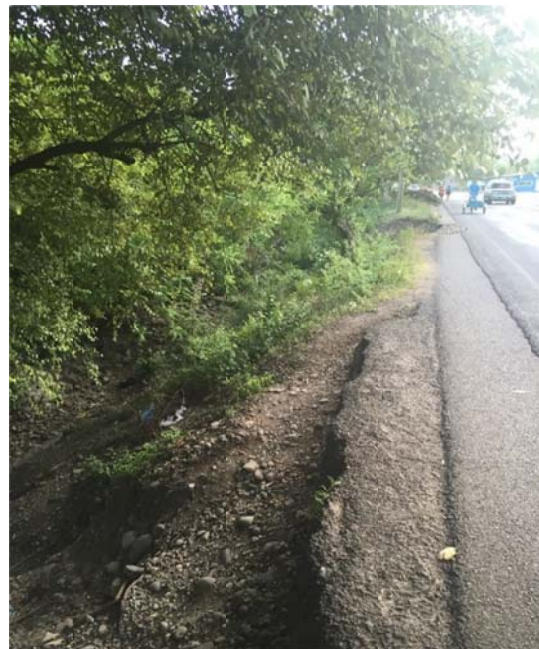
Socavación del hombro izquierdo.
