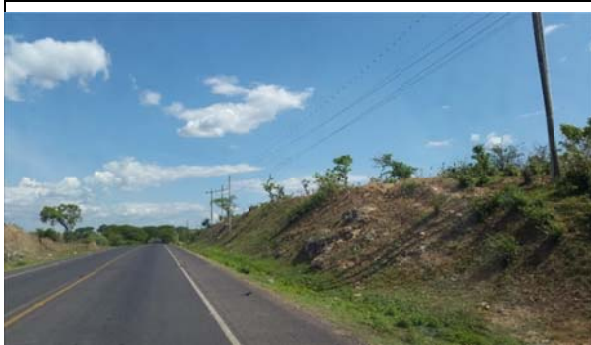
Talud sobre depósitos de tobas alterados, desarrollando ya una capa superficial de suelo. Parcialmente vegetado, 13°16'5"N/87°10'42"O.
