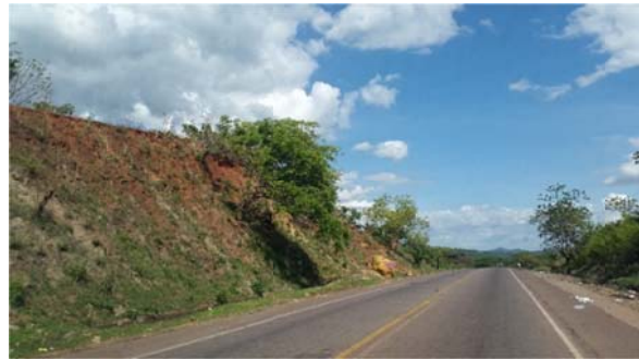
Talud sobre suelo naranja y tobas alteradas cubierto parcialmente por vegetación, 13°6'17"N/87°4'39"O.
