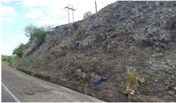
Talud sobre depósitos de tobas alterados. Desarrollando ya una capa superficial de suelo, 13°20'42"N/87°15'27"O.
