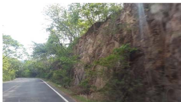
Talud sobre rocas riolíticas. Vertical con alta fracturación, 13°6'17"N/87°4'39"O
