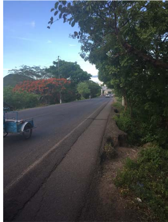
Vista hacia atrás, donde se ubica el puente metálico sobre el Río Guasirope. Véase socavación hombro izquierdo.
