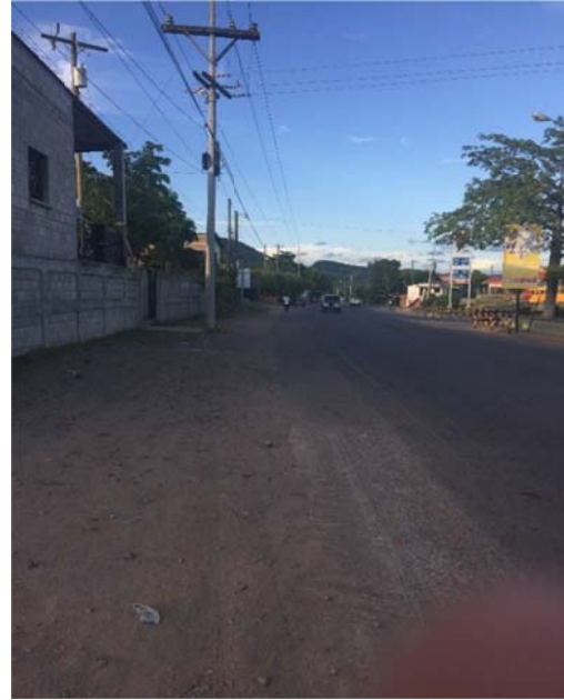
Lado derecho de la carretera. Obsérvese la falta de drenaje longitudinal – cuneta.
