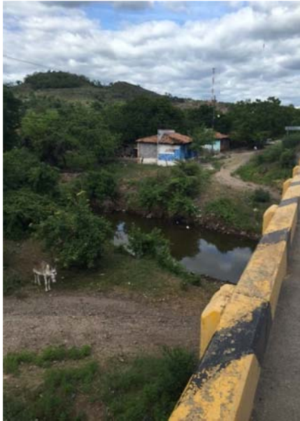
Vista aguas arriba.
