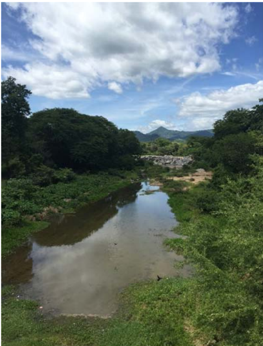
Vista aguas arriba.
