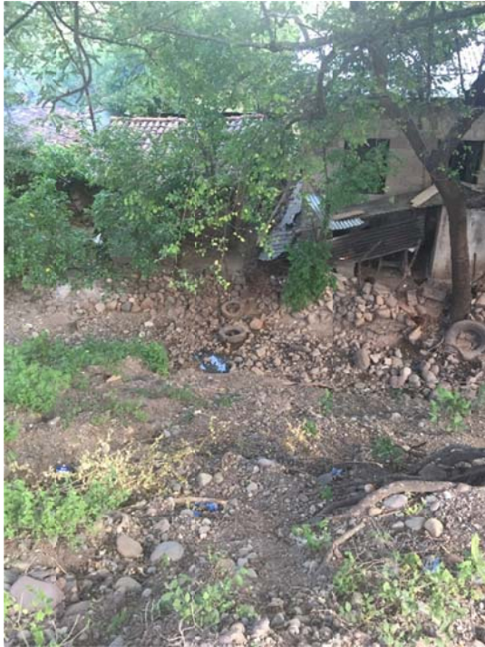
Corredero en la pata del talud del lado izquierdo de la carretera.
