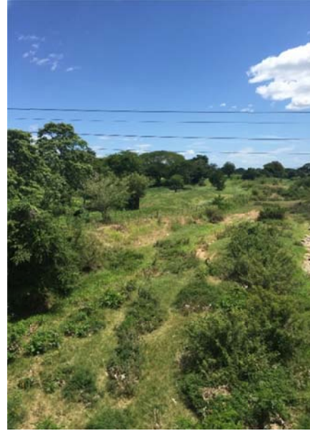
Vista aguas abajo, margen izquierda.
