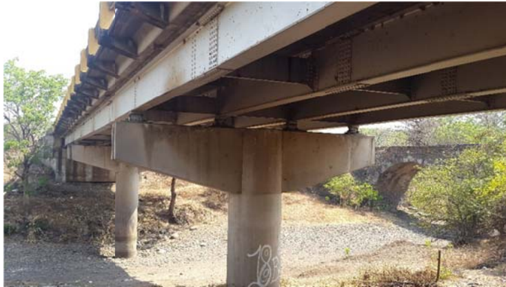
Puente que es parte de la rehabilitación y está cercano al puente sujeto a protección
