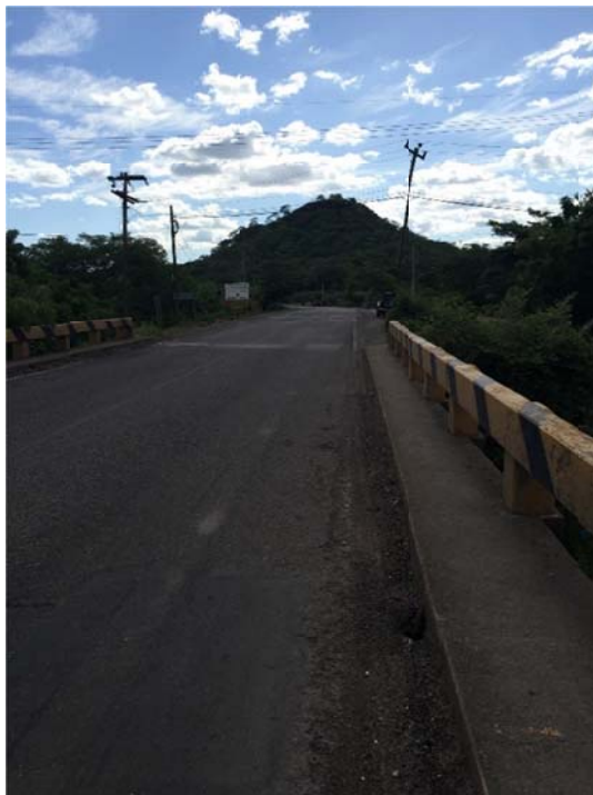
Vista sobre el puente, hacia Jícaro Galán.
