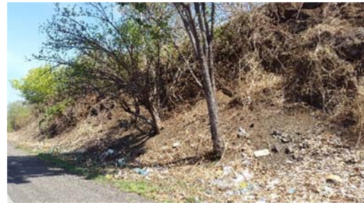
Talud sobre suelo, 13°25'5"N/87°23'15"O.
