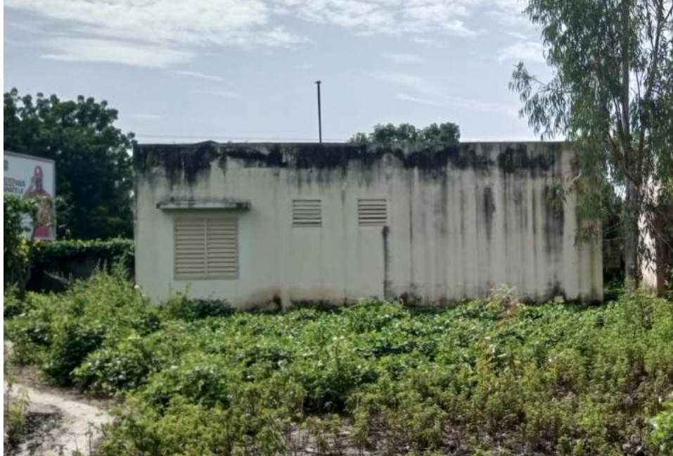
Photo 1 : Vue extérieure du Bloc administratif
