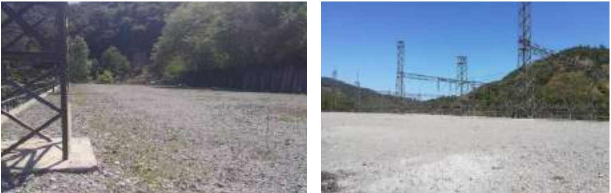
Imagen 2 - 3. Área de Ampliación Subestación El Cajón
