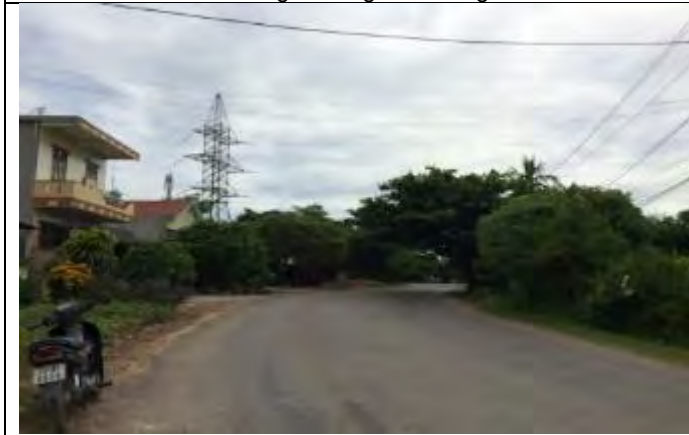
The intersection point of Hà Huy Tập road at Km2+271
