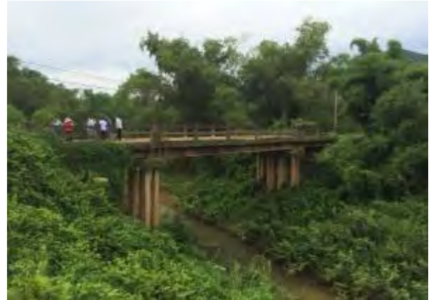
Km4+179.66: Hoi Met bridge
