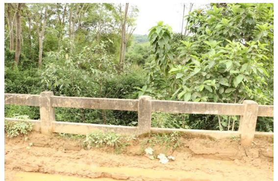
The Existing Khe Dat Bridge
