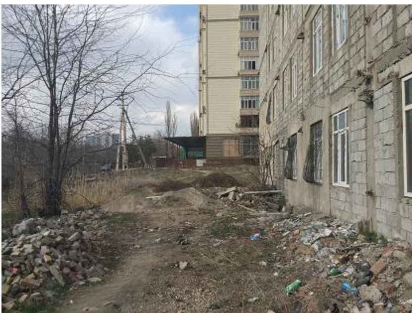
Отходы вблизи строящихся сооружений
