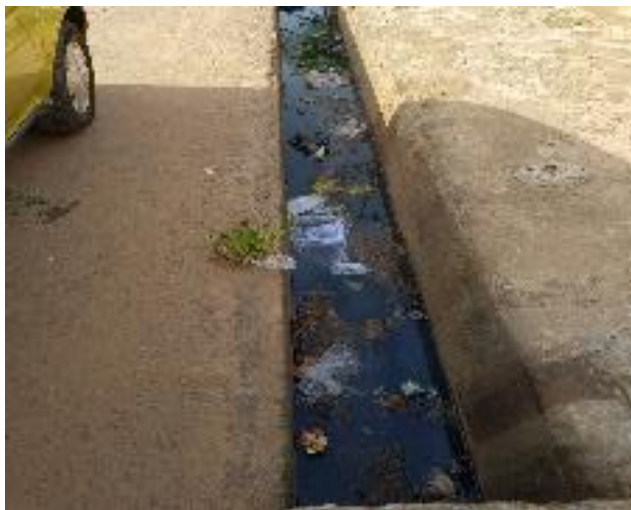
Photo 10 : Caniveaux obstrué par les déchets dans la ville de Tiassalé
