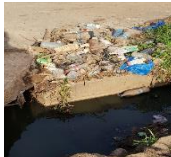
Photo 10 : Caniveaux obstrué par les déchets dans la ville de Tiassalé
