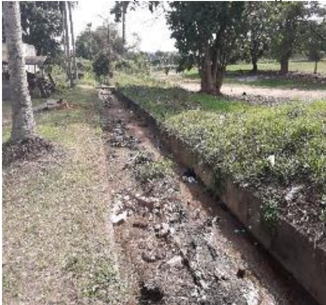
Photo 03 : Canalisations à ciel ouvert destinée à l'évacuation des eaux pluviales obstruée à Bingerville
