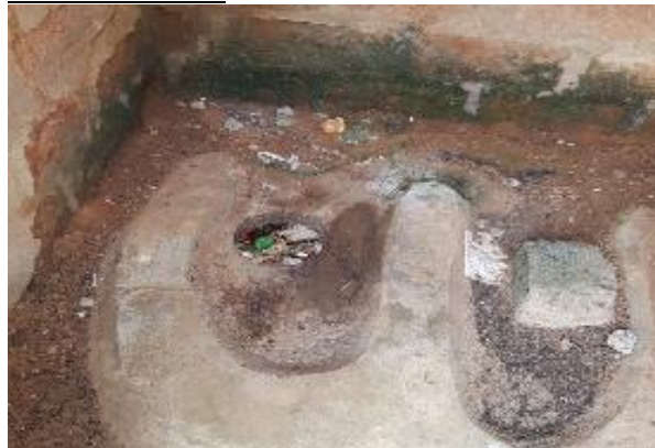
Photo 09: Gestion des blocs de latrines dans les écoles à Tiassalé
