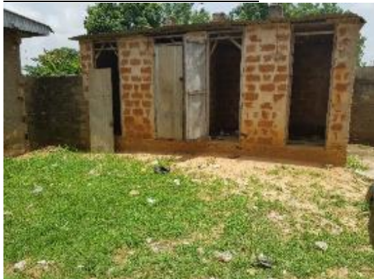
Photo 08: Gestion des blocs de latrines dans la formation sanitaires de Tiassalé
