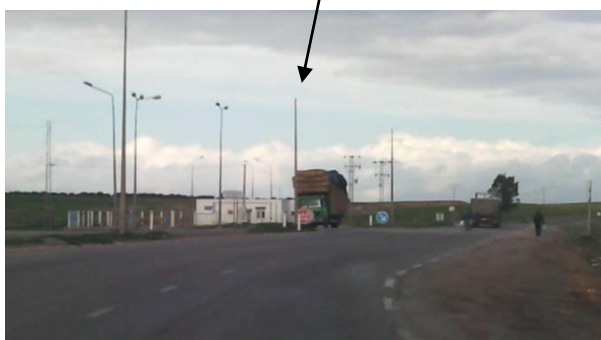
Station de pompage de gaz
