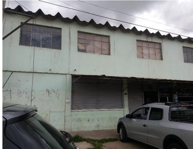
Fotografía 18 Condiciones externas del inmueble, fachada.
