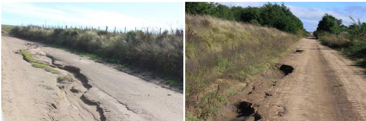
Foto 3-8. Cárcavas producidas por procesos de erosión hídrica actual.
