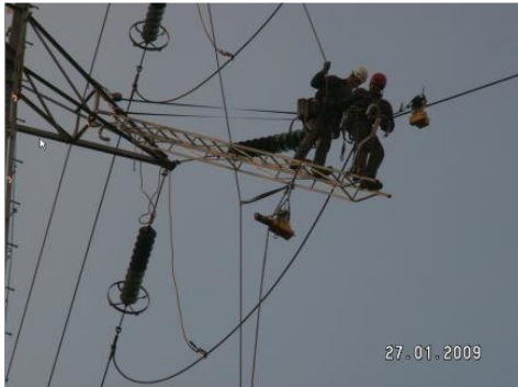
Photo 23: Travaux sur les pylônes, Harnais et chaussures de sécurité
