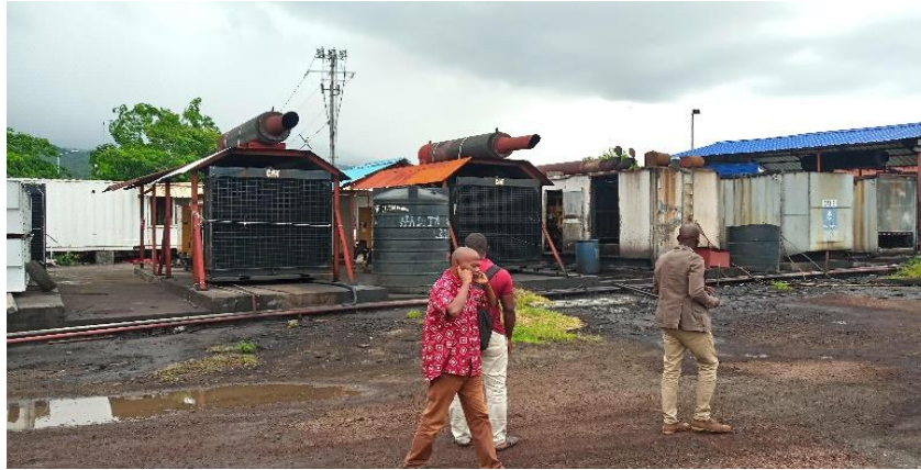
Photo 2: Centrale thermique diesel d'Itsambouni
