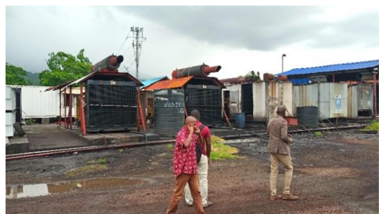
Photo 19: Niveau de bruit dépassant les 100 dBA à la centrale d'Itsambouni
