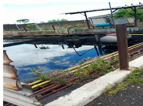
Photo 12 : réservoir d'huiles usagées à Voidjou
