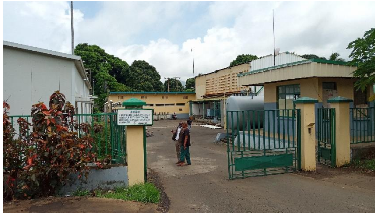
Photo 4: Centrale thermique diesel de Trénani
