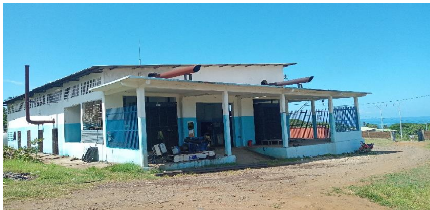
Photo 3: Centrale thermique diesel de Fomboni
