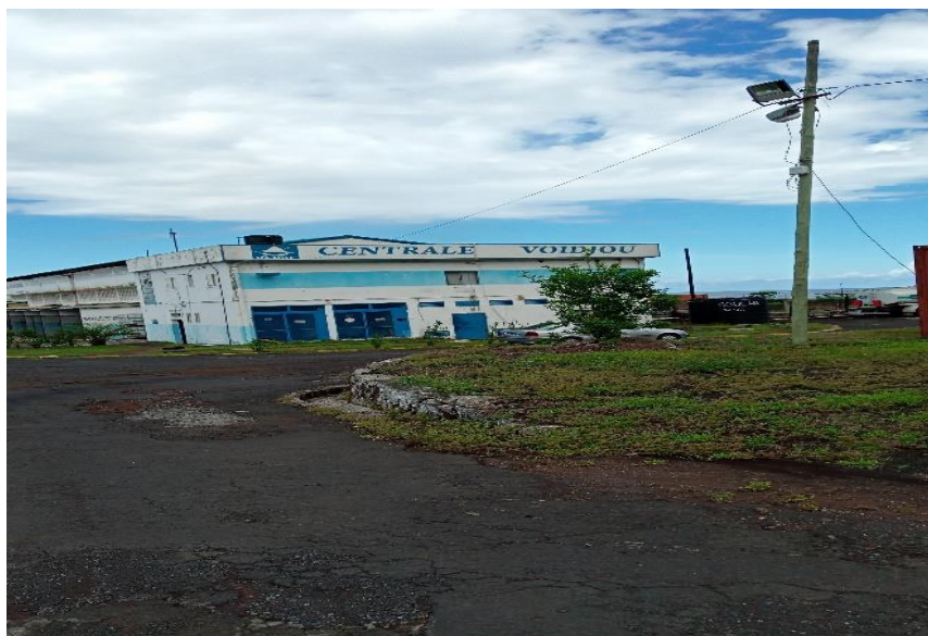
Photo 1: Centrale thermique diesel de Voidjou
