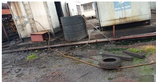
Photo 18: Mélange des huiles et des eaux pluviales à la centrale d'Itsambouni
