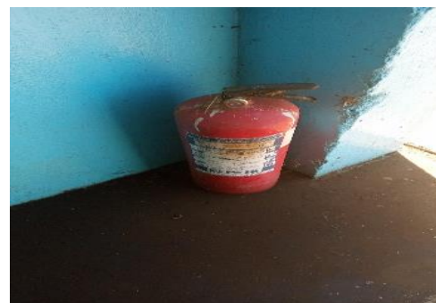
Photo 15 : Extincteurs périmés et défectueux à la centrale Fomboni
