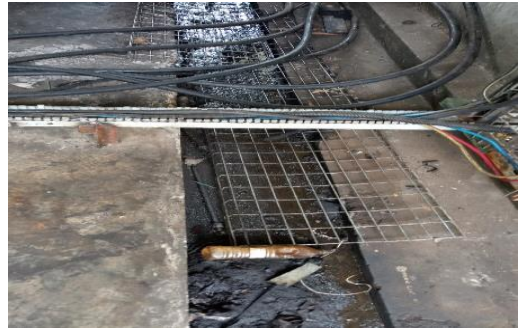
Photo 17 : Réseau d'assainissement défectueux à la centrale de Trénani
