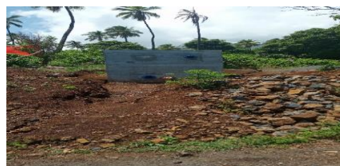
Photo 21: Équipement hydraulique prévu pour la conduite d'eau de la centrale hydroélectrique de Domoni
