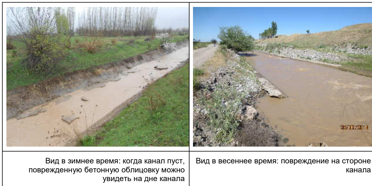
Рисунок 15: Канал Правая ветка между 158 + 50 км и 191 + 10
