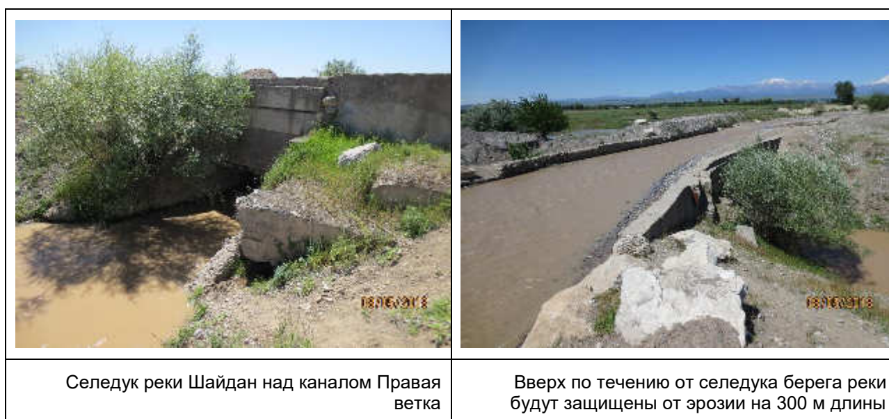
Рисунок 11: Селедук/селепроводное сооружение над каналом Правая ветка
