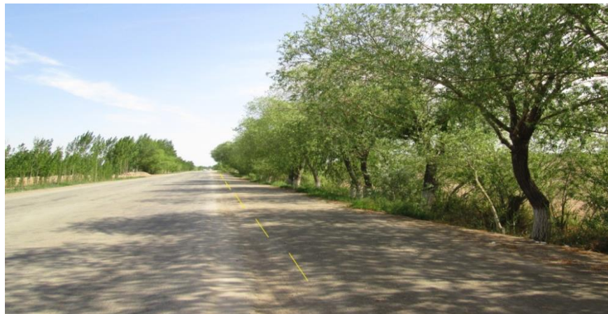
Рис. 3.3 Участок строительства нового УРВ “Шимом” в Берунийском районе
