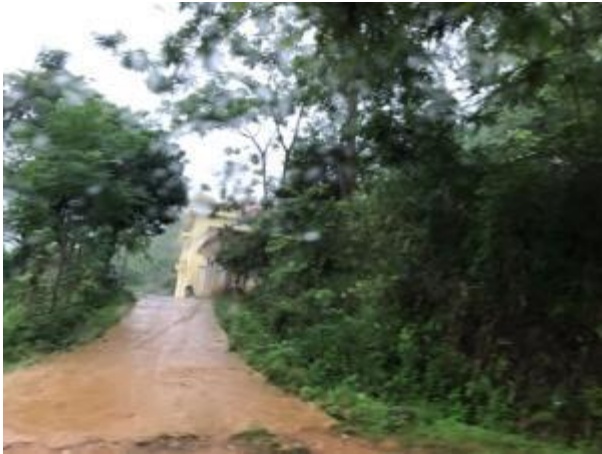
Km6+800 (Bridge) Trang Son commune
