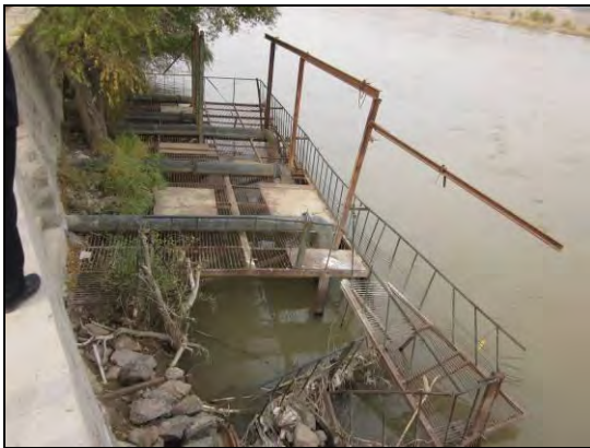
现状稀土公司取水口现状
