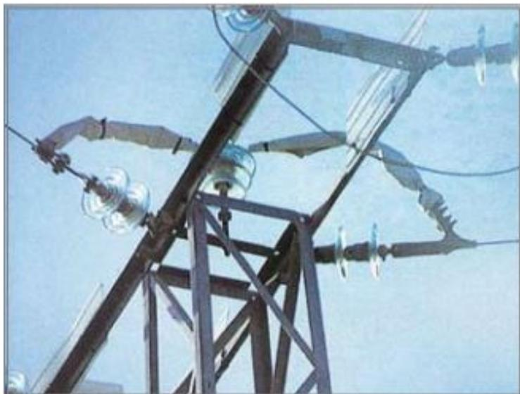
Consiste en un aislamiento parcial de la fase, previene contacto fase-tierra, se cubren los puentes y las grapas con aislante o se sustituye el puente por cable seco, las dimensiones de la cobertura dependen del puente. Se pueden utilizar diversos materiales. Tiene un costo medio con buena eficacia.
