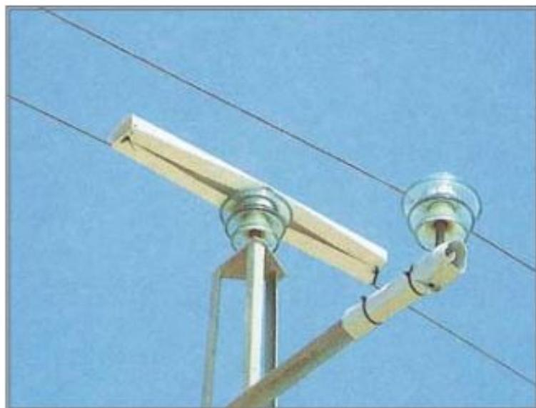
Consiste en un aislamiento parcial de la fase, previene contacto fase-tierra, se cubre el aislador y parte del conductor, 40 cm a ambos lados del aislador. Se pueden utilizar diversos materiales. Tiene un costo medio con buena eficacia. La durabilidad depende el material utilizado.
