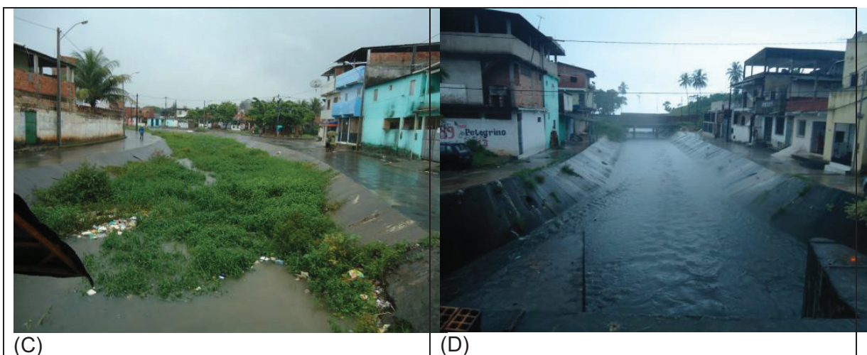
FIGURA 4-10 - Vegetação da APP do Rio Paraguari sobre influencia direta da ADA do empreendimento VLT/Monotrilho do Subúrbio apresentando fortes evidências de antropização. (A) Apresenta o local onde a ADA do empreendimento cruza o Rio Paraguari (seta branca), (B e C) Lixo e gramíneas no leito do Rio Paraguari, (D) Trecho do Rio Paraguari na Suburbana, próximo à linha do trem. (Fonte: INEMA, 2013 7 , SANTOS, 2010 6 )
