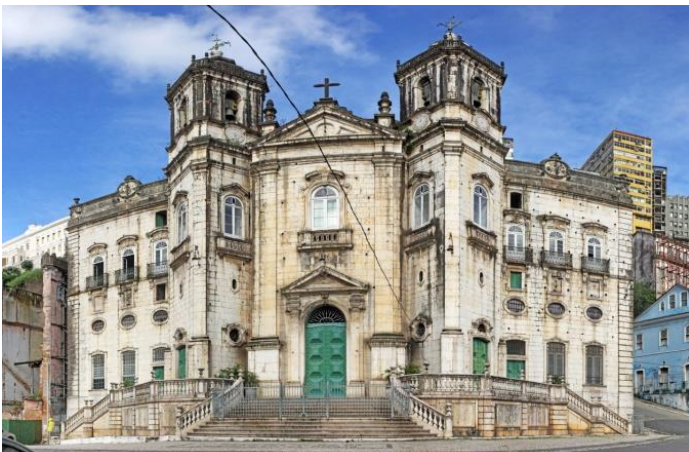
Figura 44 – Visão parcial da fachada da Igreja de Nossa Senhora da Conceição da Praia. Foto: Arivaldo Leão de Amorim
