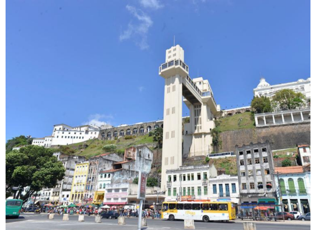
Figura 56 – Elevador Lacerda visto a partir da Capitania dos Portos de Salvador. Fonte: http://www.bahia-turismo.com/salvador/elevador-lacerda.htm
