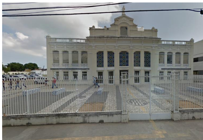
Figura 39 – Fachada Frontal do imóvel após a reforma (atual Campus da Faculdade Estácio de Sá. Fonte: Google Street View
