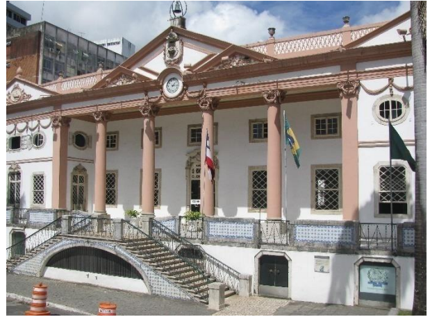
Figura 58 – Visão parcial da fachada do Palácio da Associação Comercial da Bahia. Fonte: https://pt.wikipedia.org/wiki/Associa%C3%A7%C3%A3o_Comercial_da_Bahia
