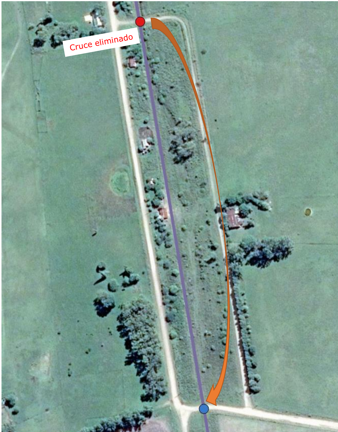
Figura 3-54: Cruce eliminado – Camino rural (km 249+896)
