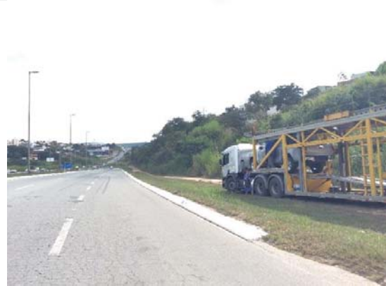
Visada 36F: ADA de LP/LI - ITV 53-A a 55, km 120+740 - pista leste, Divinópolis -MG. Trecho de ampliação das obras em local com baixas declividades.
