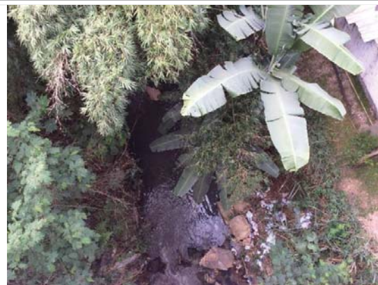
Visada 42F: ADA de LP/LI - ITV 58 a 62-C, km 128+540 - pista leste/oeste, Divinópolis-MG. Condição atual do leito do Córrego do Almoço sob a rodovia. Observa-se a deposição de lixo urbano.
