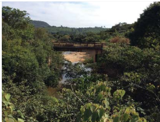
Foto 4.1.2.7-25: km 160+000 - pista Oeste, Pedra do Indaiá-MG. Detalhe do Rio Lambari, com fundo rochoso em área de depósito aluvionar.
