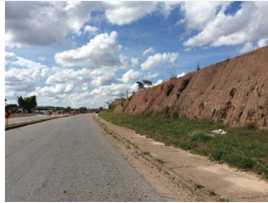
Visada 40F: ADA de LIC - ITV 54, 56 e 57, km 125+030- pista oeste, Divinópolis-MG. Implantação de viaduto em local de solos bem evoluídos, apresentam boa capacidade de compactação.
