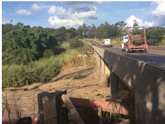
Visada 17F: ADA de Operação, km 89+910 - pista oeste, Itaúna-MG. Travessia sobre o Rio São João, nota-se o leito rochoso do rio no segmento.
