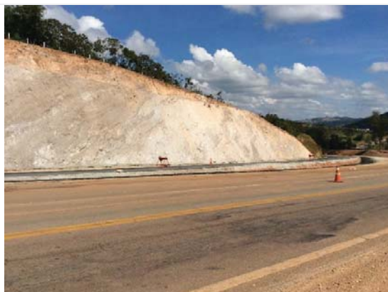
Visada 7F: ADA de LIC– ITV 14 a 22, km 71+080 - pista oeste, Mateus Leme Trecho em obras. Detalhe para as baixas declividades do segmento.
