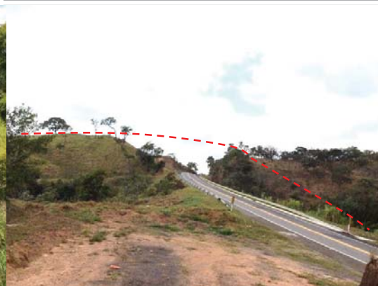
Foto 4.1.2.7-12: 256+900 Pista Oeste, Piumhi-MG. Serra da Canastra. Relevo movimentado cortado para a implantação da rodovia MG-050 – Região Cárstica do Grupo Bambuí.
