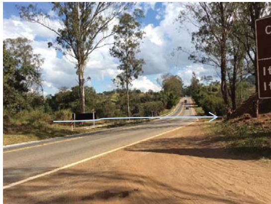
Visada 11F: ADA de operação, km 78+530 - pista leste/oeste, Itaúna-MG. Local da travessia sobre o Córrego das Laranjeiras.
