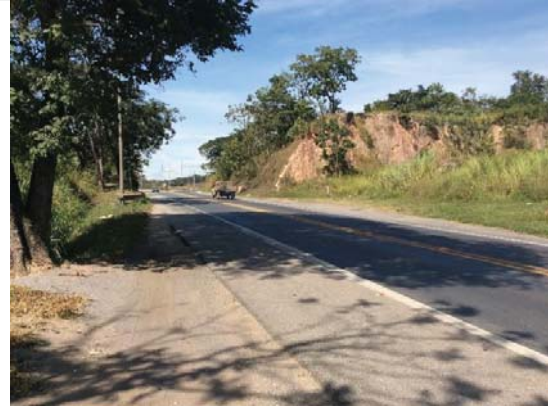
Visada 34F: ADA Operação, km 120+500 - pista leste/oeste, Divinópolis -MG. Forma de relevo residual na ADA de Operação do empreendimento local onde será realizada uma correção geométrica.
