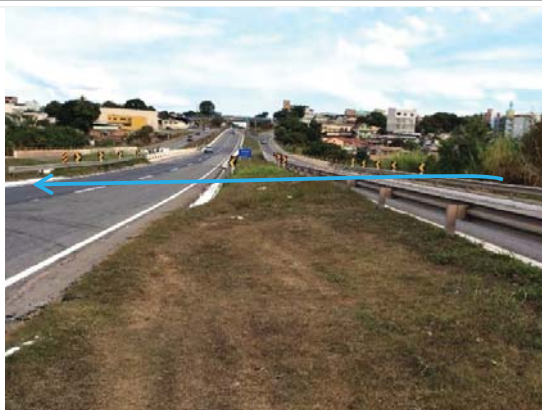
Visada 41F: ADA de LP/LI - ITV 58 a 62-C, km 128+480 - pista leste/oeste, Divinópolis-MG. Local onde serão realizadas obras de melhorias. Ponte o Córrego do Almoço.
