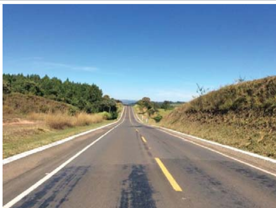
Visada 103F: ADA de LP/LI - ITV 169-A, km 393+850 / MG-050 - pista leste/oeste, São Sebastião do Paraíso-MG. Futuro trecho de obras – implantação de terceira faixa em local com rampas alongadas associadas ao Planalto da Bacia do Paraná.
