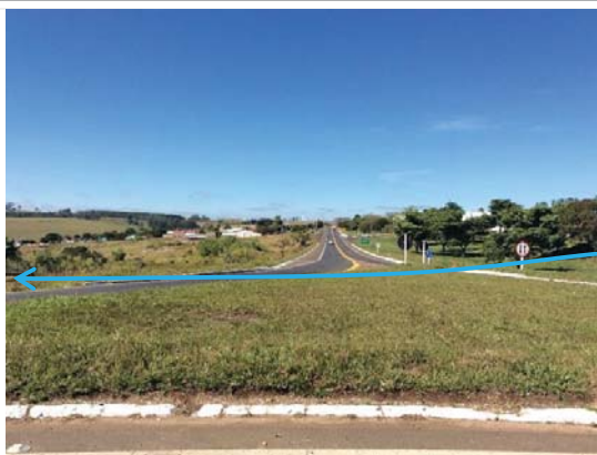
Visada 104F: ADA de LP/LI - ITV 173 a 178-B, km 402+900/MG-050 E km 0+000 da BR-491, São Sebastião do Paraíso-MG. Futuro trecho de obras em média vertente com baixas declividades. Detalhe para a travessia do Afl I do Córrego da Fazendinha.
