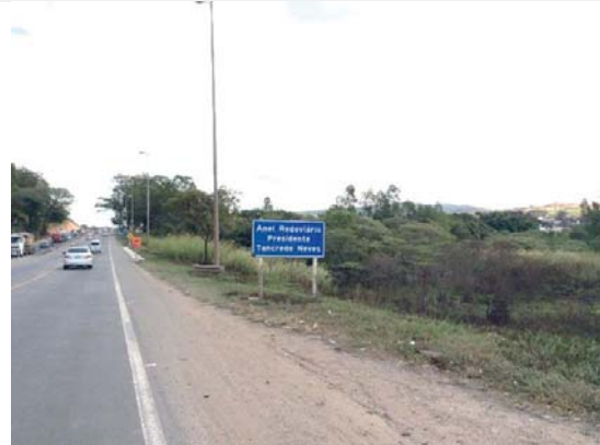
Visada 38F: ADA de LIC - ITV 54, 56 e 57, km 125+030- pista oeste, Divinópolis-MG. Devido as baixas declividades não serão necessárias grandes movimentações de solo na execução das obras.
