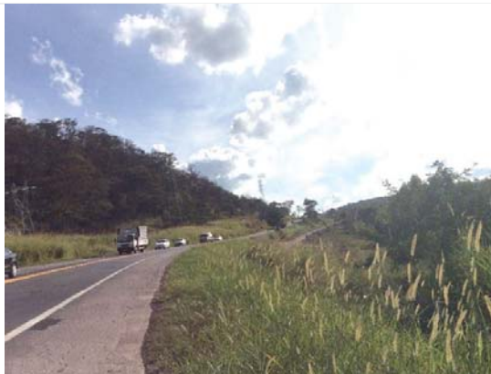
Visada 18F: ADA de LP/LI - ITV 33 a 34-A, km 92+290 - pista oeste, Itaúna-MG. Trecho de correção de geometria, onde o aterro será prolongado. Não ocorrerá intervenção direta em curso d'água nesse ponto.
