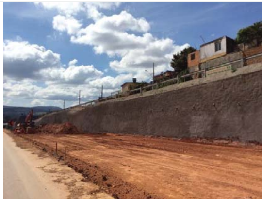
Visada 6F: ADA de LIC, km 73+150 - pista leste, Juatuba-MG. Obras de terraplanagem e estabilização de talude.
