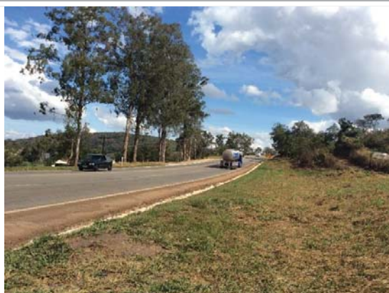
Visada 15F: ADA de LP/LI - ITV 26, km 83+000 - pista leste, Itaúna-MG. Trecho de aclave onde será implantada terceira faixa.
