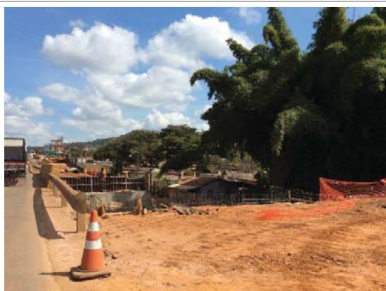
Visada 9F: ADA de LIC– ITV 14 a 22, km 73+660 - pista oeste, Mateus Leme, trecho em obras. Obras de ampliação sobre o Ribeirão da Cachoeira.
