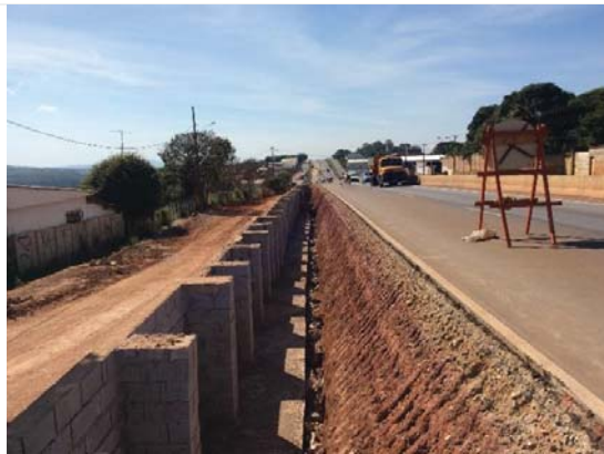
Visada 5F: ADA de LIC, km 67+320- pista oeste, Mateus Leme Trecho em obras – ITV 14 a 22. Detalhe para as baixas declividades do segmento.
