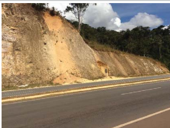
Visada 10F: ADA de LIC– ITV 14 a 22, km 75+280- pista leste, Mateus Leme, trecho em obras. Talude em trecho de obras sofrendo processo erosivo.
