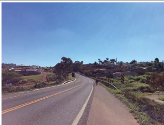
Visada 105F: ADA de LP/LI - ITV 177 a 178-C , km km 637+990 da BR-265, São Sebastião do Paraíso-MG. Futuro trecho de obras em local com relevo
