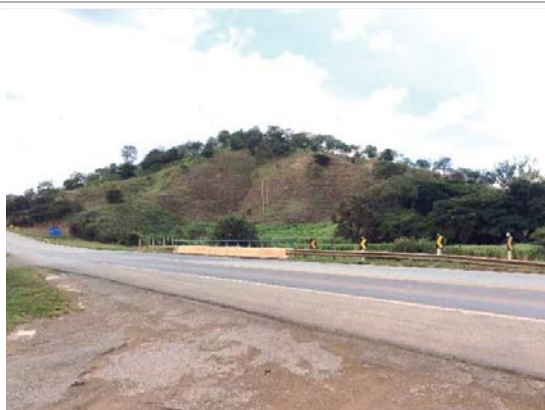
Visada 13F: ADA de LP/LI - ITV 25, km 81+890 - pista leste/oeste, Itaúna-MG. Local de travessia do Córrego Batata o qual não deve sofrer intervenções diretas.
