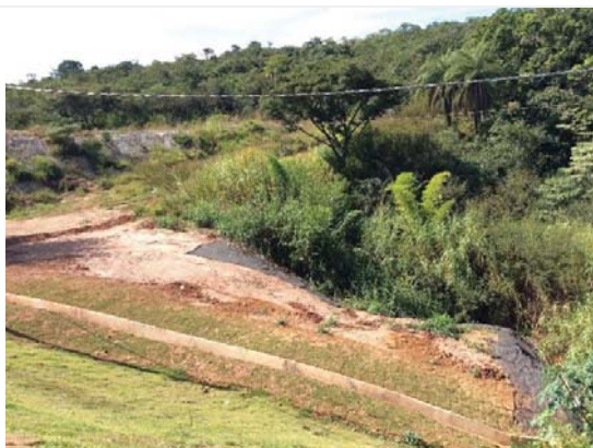
Visada 8F: ADA de LIC– ITV 14 a 22, km 72+780 - pista oeste, Mateus Leme Trecho em obras. Obras de estabilização de talude, Córrego Sesmaria.
