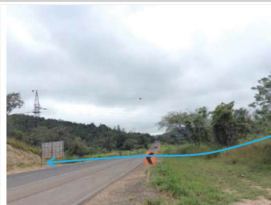
Visada 98F: ADA de LIC – ITV 158, km 373+740/ MG-050 - pista oeste, Itau de Minas-MG. Trecho em obras sobre o Afl. I do Córrego Calazarte.
