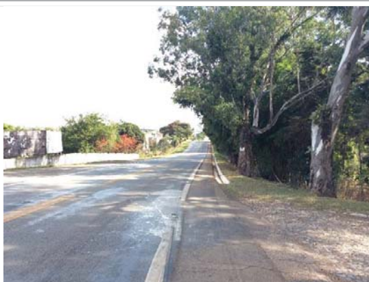
Visada 16F: ADA de LP/LI - ITV 26, km 83+510 - pista leste, Itaúna-MG. Trecho com baixas declividades no final da obra.
