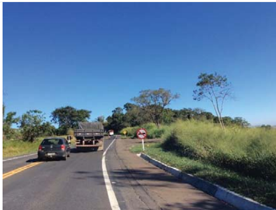
Visada 102F: ADA de LP/LI - ITV 166-A, km 382+620/ MG-050 - pista leste, Pratápolis-MG. Futuro trecho de obras – correção de geometria – em local sinuoso.
