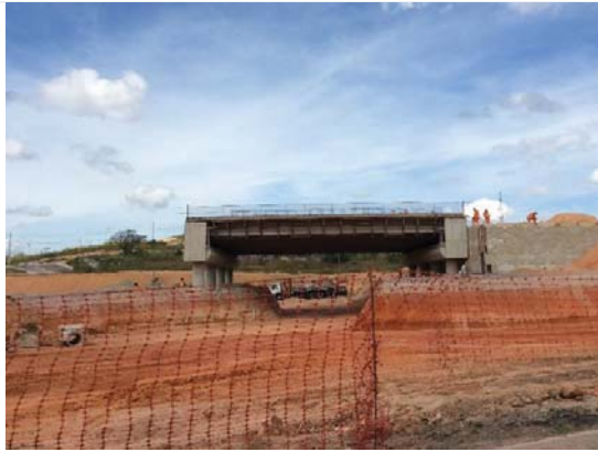
Visada 39F: ADA de LIC - ITV 54, 56 e 57, km 125+030- pista leste/oeste, Divinópolis-MG. Implantação de viaduto em local de solos bem evoluídos, apresentam boa capacidade de compactação.
