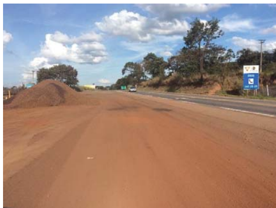
Visada 19F: ADA de LP/LI - ITV 33 a 34-A, km 96+640 - pista leste, Itaúna-MG. Depressão Sanfranciscana, trechos com baixas declividades.
