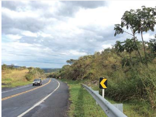
Visada 80F: ADA de LP/LI, ITV 129 e 129-B, km 303+080 – pista leste/oeste, Capitólio-MG. Rocha intemperizada e pacotes de solo pouco desenvolvidos na área de intervenção.
