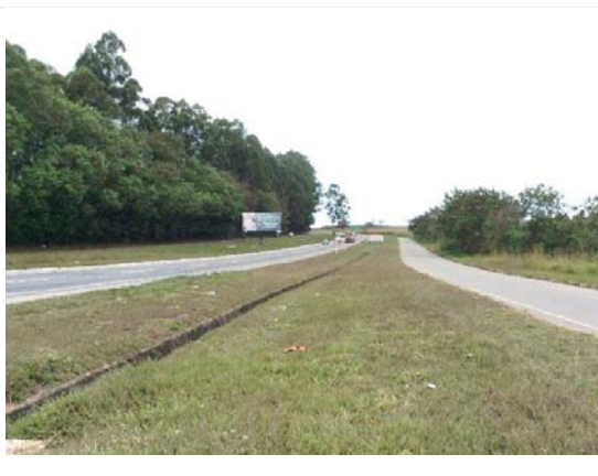
Visada 43F: ADA de LP/LI - ITV 58 a 62-C, km 128+480 - pista leste/oeste, Divinópolis-MG. Local
