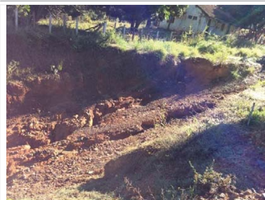
Visada 100F: ADA de LIC – ITV 161, 162 e 163, km 380+600/ MG-050 - pista leste, Fortaleza de Minas-MG. Processo erosivo às margens do Córrego da Água Limpa.
