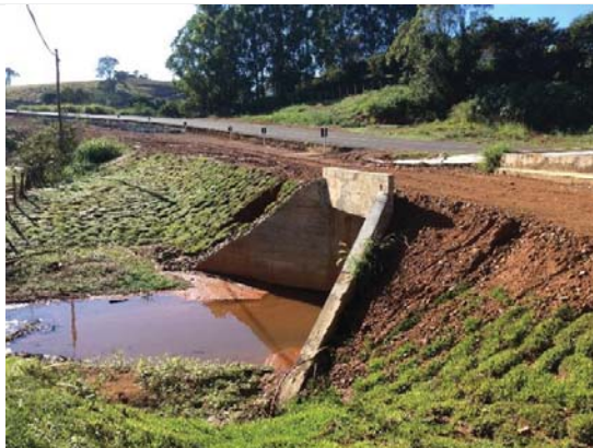
Visada 101F: ADA de LIC – ITV 161, 162 e 163, km 380+600/ MG-050 - pista leste, Fortaleza de Minas-MG. Processo erosivo às margens do Córrego da Água Limpa.
