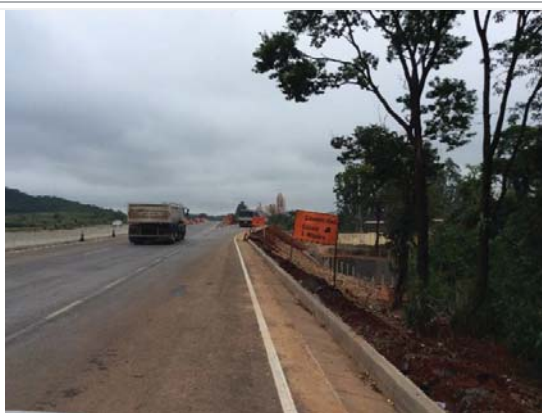
Visada 97F: ADA de LIC – ITV 158, km 372+580/ MG-050 - pista oeste, Itau de Minas-MG. Trecho em obras, em local com baixas declividades.
