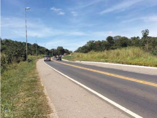
Visada 35F: ADA de LP/LI - ITV 50 e 51-A, km 120+740 - pista leste/oeste, Divinópolis -MG. Final do trecho de construção da correção geométrica e duplicação.
