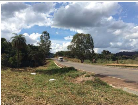
Visada 14F: ADA de LP/LI - ITV 25, km 82+950 - pista leste, Itaúna-MG. Trecho com declividades entre 0 a 20%.
